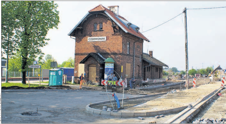
Przy dworcu w Czerwonaku powstaje parking, który ułatwi przesiadkę na pociąg.
