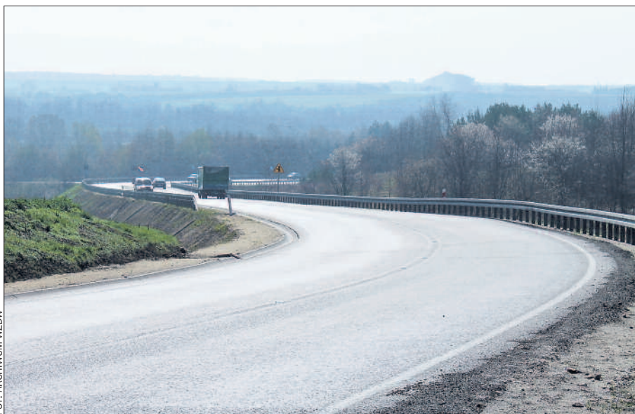
W 2013 r. ukończono m.in. przebudowę ponad 42 km drogi nr 434, od trasy nr 36 do Śremu.
