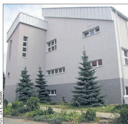
Fragment elewacji budynku Zespołu Szkół Rolniczych po termomodernizacji.
