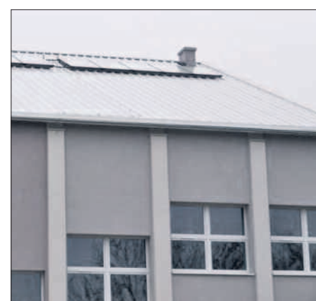
Na nowym dachu zainstalowano kolektory słoneczne.
