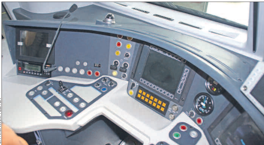
...i po zakończeniu montażu.
