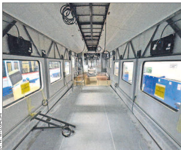
Przedział w trakcie zabudowy...
