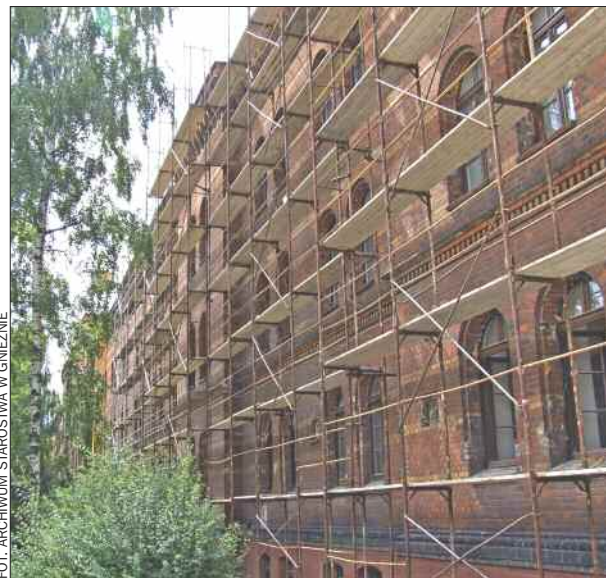
Prace budowlane w koszarach już się rozpoczęły. W złym stanie są m.in. fundamenty, ściany piwnic oraz parter budynku. Koniec inwestycji zaplanowano w grudniu 2012 r.
