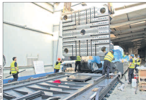
FOT. ARCHIWUM FIRMY Montaż urządzenia sfinansowanego ze środków WRPO.
