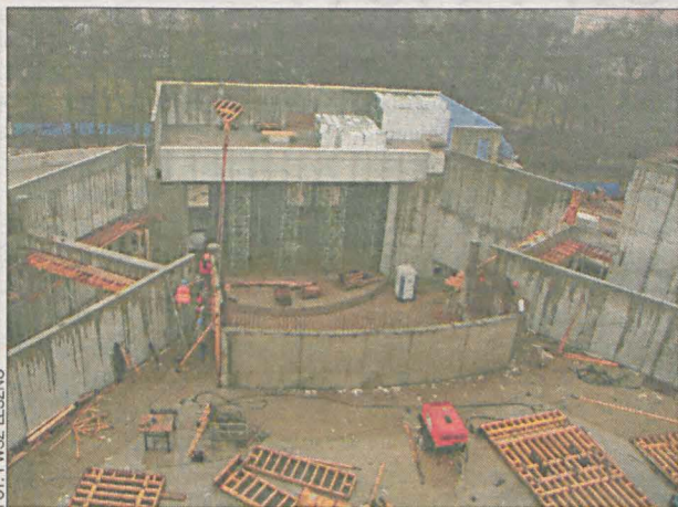
Z budowlanych rusztowań szybko wyłania się bryła nowej auli.
