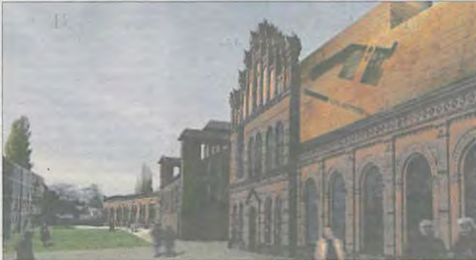
FOT. ARCHIWUM GRUPY PROJEKTOWEJ „NOWA GAZOWNIA”
