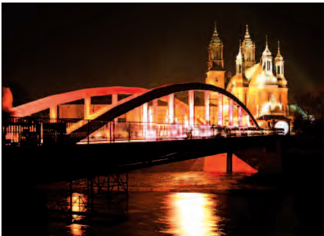
Budowa Mostu Cybińskiego między Śródką a Ostrowem Tumskim w Poznaniu (dofinansowanie ze ZPORR: 7.125.000 zł).
