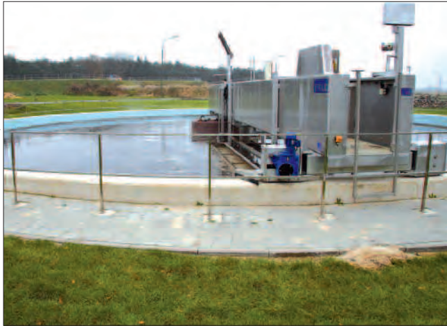
Modernizacja oczyszczalni ścieków w Baranowie (dofinansowanie ze ZPORR: 6.489.996 zł).
