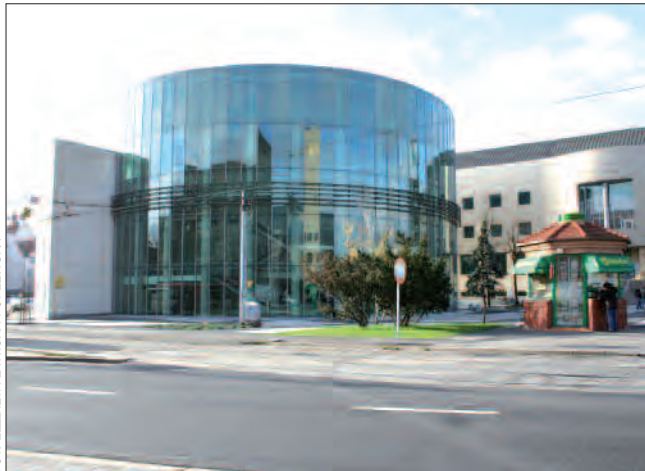
Budowa sali koncertowej, etap III, rozbudowa Akademii Muzycznej w Poznaniu (dofinansowanie ze ZPORR: 19.184.037 zł).
