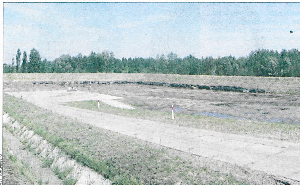
Skladowisko odpadów niebezpiecznych w Koninie zrealizowane zostało przy pomocy finansowej WFOŚiGW.
