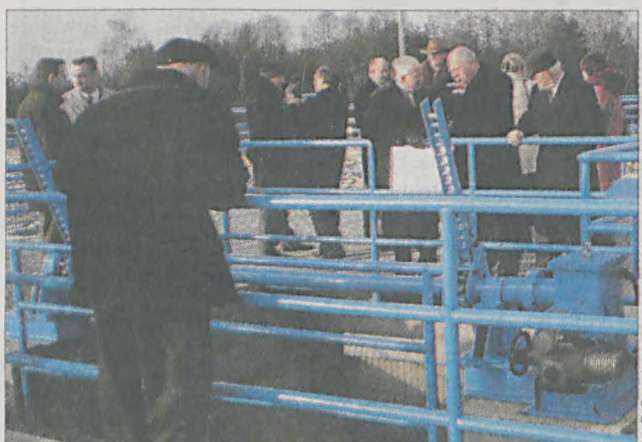
Przedsięwzięcia chroniące wodę mają szczególne znaczenie dla Wielkopolski. Na zdjęciu: otwarcie zbiornika retencyjnego na Powie w Starym Mieście, goście oglądają urządzenia zapory czołowej.
