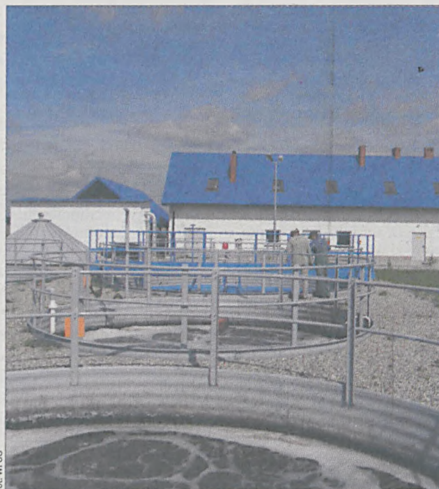
Nowoczesny obiekt w Łęce Opatowskiej wraz z rozbudowywaną siecią kanalizacyjną obsługiwać będzie pięcioletnią gminę i przyczyni się do ograniczenia zanieczyszczeń oraz poprawy czystości rzek Pomianki i Proсны
