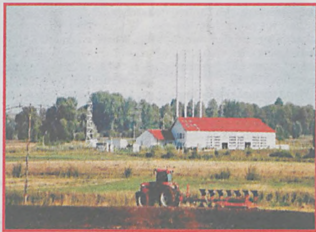
Ciepłownia bez dymów? – w Wielkopolsce to też możliwe. Na zdjęciu siedziba Geotermii Pyrzyce sp. z o.o. w Szczecińsku.
