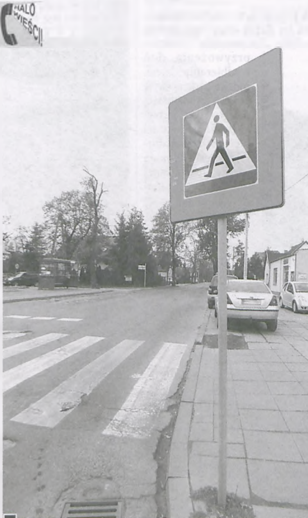
Znak przy przejściu dla pieszych na ul. Poniatowskiego (plac Edmunda Bojanowskiego) mogły uszkodzić mijające się w tym wąskim miejscu autobusy. Na przestawionej tablicy, od strony jezdni widoczne ślady po zdrapaniu farby fot. Hanna Siatka
