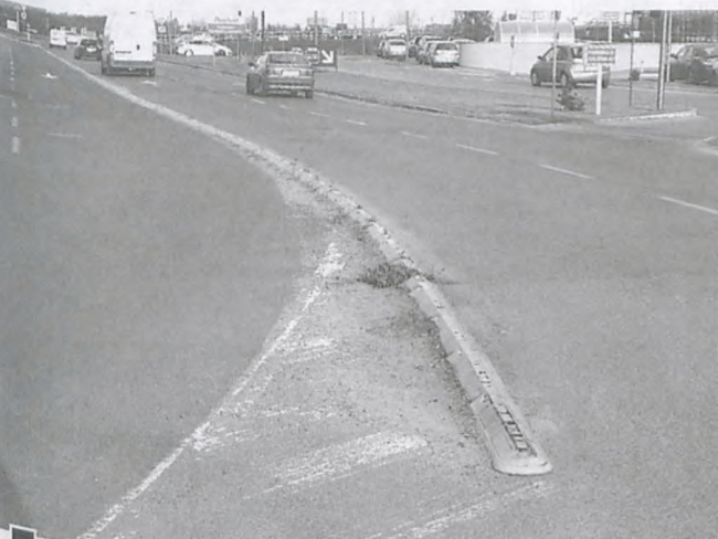
Ciąg separatorów na ul. Głogowskiej, na wysokości Galerii A2 fot. R. Wojtyniak
