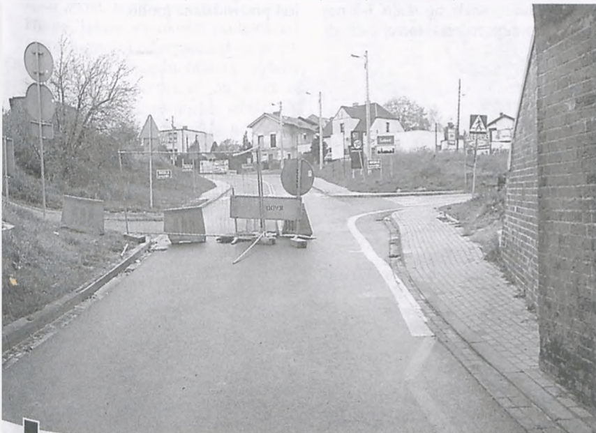
Zamknięty przejazd pod wiaduktem w ul. Krętej. O tej niedrożności brakuje informacji tak od strony ul. Krętej, jak i Armii Poznań fot. Hanna Siatka
