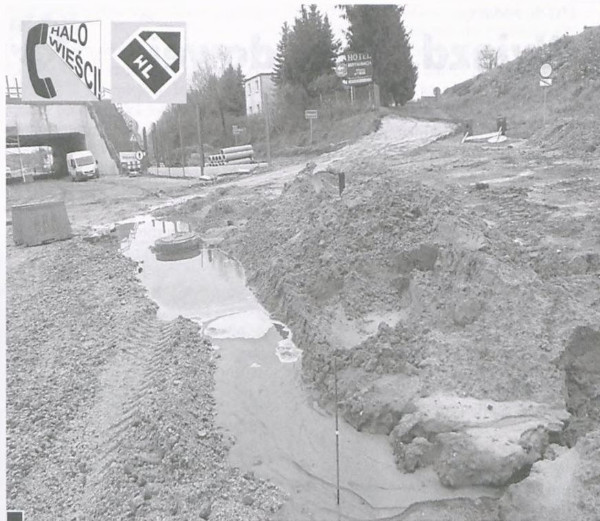
Przebudowa ul. Krętej w Łęczycy, za wiaduktem w Luboniu. Wciąż nieuregulowane problemy: z odwodnieniem gruntu oraz budynku mieszkalnego z adresem: Poznańska 75 (centralnie w głębi), którego nie ma na mapie (czytaj w „WL” 10-2017, str. 33) fot. Hanna Siatka
