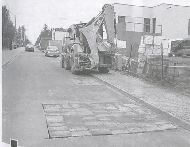
W ul. 1 Maja wycięto asfalt w dziewięciu fragmentach jezdni. Pozostaje mieć nadzieję, że zostanie przywrócona do należytego stanu fot. Paweł Wolniewicz
