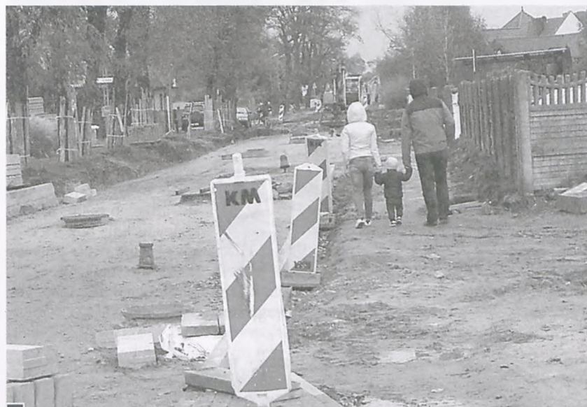
Przedłużające się roboty przy budowie odcinka ul. Żabikowskiej od Sobieskiego do Buczka nastrożają wiele trudności tamtejszym mieszkańcom fot. Hanna Siatka
