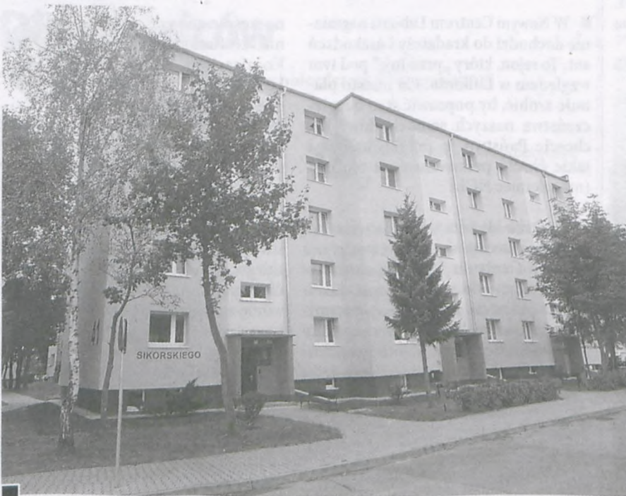
Blok nr 41 przy ul. Sikorskiego – po remoncie fot. Jan Błaszczak
