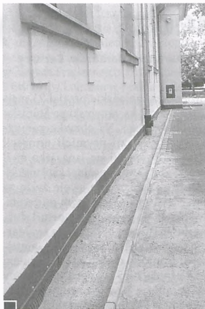
Prace przy izolacji fundamentów kościoła fot. Paweł Wolniewicz
