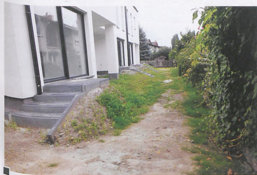
Podniesiony o blisko metr teren nowej zabudowy. Z prawej ogródki przy szeregowcu na ul. Leśmiana. Wcześniej woda opadowa wsiąkała w grunt. Teraz, nieskanalizowana, spływa od ul. Poniatowskiego obrzeżami zabudowanego, pochyłego terenu na obszar starszego, położonego niżej osiedla fot. Hanna Siatka
