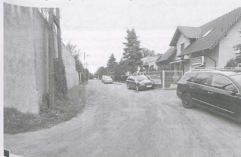
Fragment ul. Zielonej od Szafirowej w stronę Granicznej, na którym, zgodnie z wnioskiem radnego przegłosowanym przez Komisję Komunalną, miał powstać brakujący chodnik. Okazuje się, że budowany będzie cały – od placu E. Bojanowskiego do ul. Granicznej fot. Hanna Siatka
