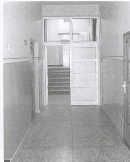
Na trzech kondygnacjach szkoły, która przed wprowadzeniem gimnazjów cała była podstawówką, uruchomiono przejścia między częściami budynku podzielonego wcześniej na G 1 i SP 3. W tym celu osadzono nowe drzwi fot. Paweł Wolniewicz
