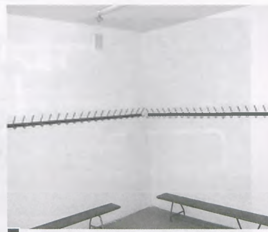
Wyremontowano szatnie przy sali gimnastycznej fot. Paweł Wolniewicz
