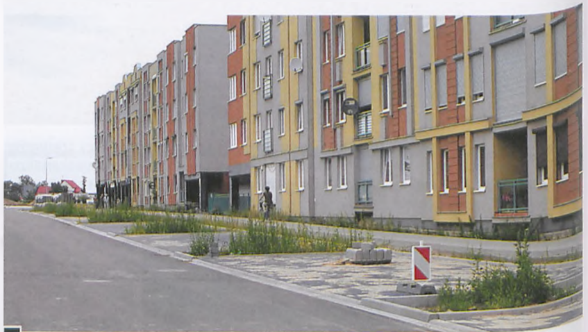
Zarys budowanej alei, krytykowanej przez uczestników ruchu. Ich zdaniem, pasy, zieleni pomiędzy miejscami postojowymi można by przeznaczyć na kolejne pola parkingowe, których w Nowym Centrum Lubonia brakuje fot. Hanna Siatka
