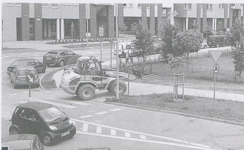
Budujący aleję Jana Pawła II ciężkim sprzętem jeżdżą po wykonanych w ub. roku (w ramach utwardzania ul. Wschodniej) chodnikach oraz trawniku
