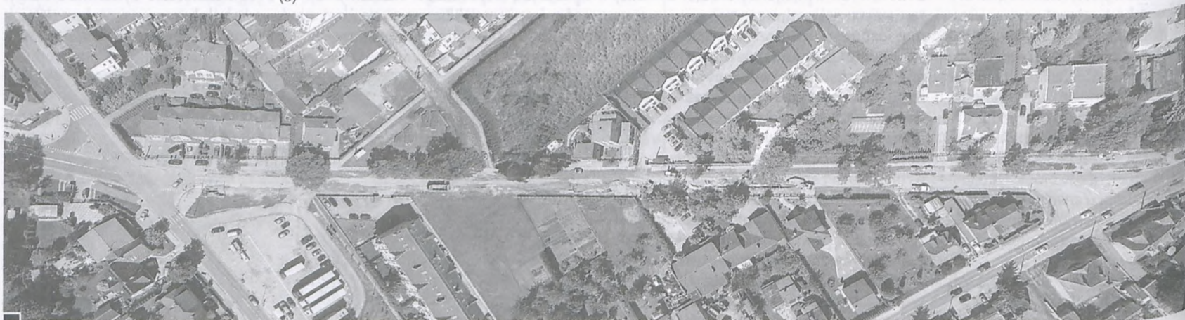
Inwestycja drogowa na ul. Żabikowskiej z wysokości 100 metrów – remontowany odcinek od skrzyżowania z ulicami: Buczka, Targową i Poznańską (z lewej) do rozwidlenia ul. Żabikowskiej i Sobieskiego (z prawej) fot. Rafał Wojtyniak
