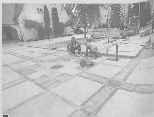
Trwa wykładanie placu przed kościołem św. Barbary różnorodną kostką granitową fot. Hanna Siatka
