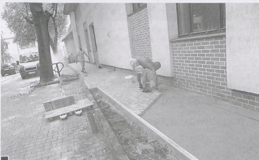
Układanie dodatkowego chodnika bezpośrednio przy budynku SP 2 od strony osiedla Lubonianka fot. Władysław Szczepaniak
