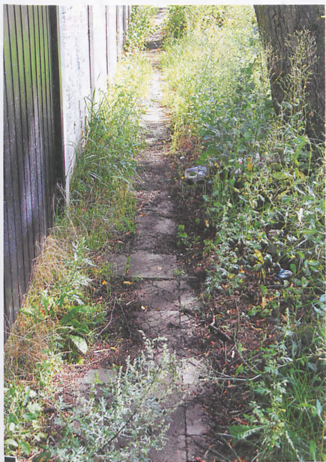
W innym miejscu chodnik na ul. Kopernika wygląda tak, jakby nikt po nim nie chodził. Nic dziwnego. Pozarastane, koślawe płytki mogą być pułapką nawet dla sprawnego przechodnia. Dla człowieka o kulach, starego, niedołężnego, pokonanie takiego przejścia to prawdziwa przeprawa. Wózek nie ma tu co szukać, zielsko wkręci się w koła.
