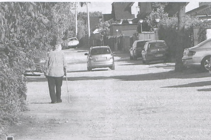
Na części ul. Leśmiana nie ma nawet chodnika. Prowizorycznie utwardzona nawierzchnia jest nieprzyjazna dla ludzi, szczególnie niepełnosprawnych i starszych fot. Hanna Siatka
