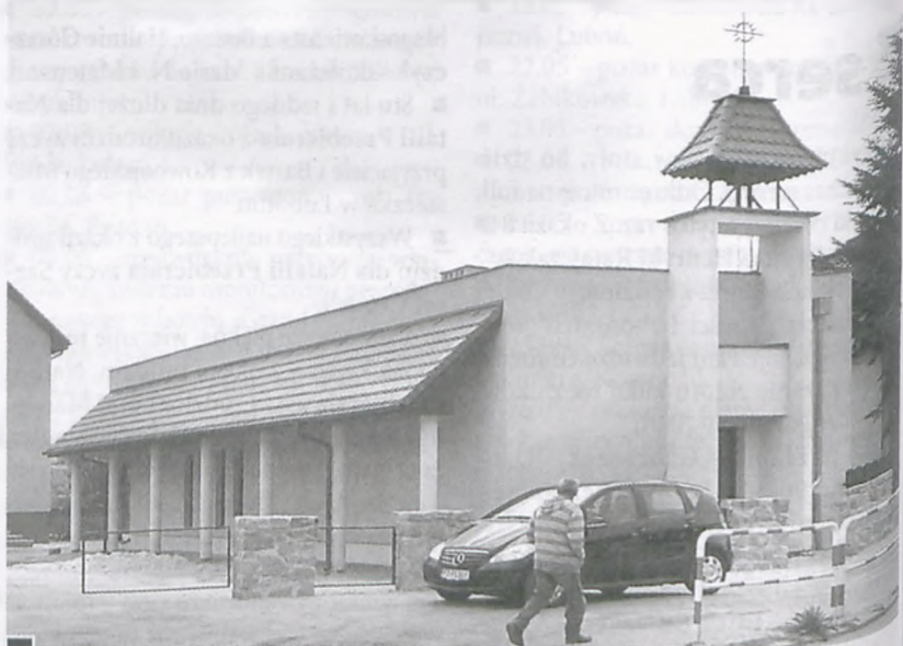
Dom parafialny w Lasku – przebudowany i zaadoptowany budynek pierwszego kościoła pw. św. Maksymiliana (czytaj „WL” 05-2017, str. 48). fot. Hanna Siatka
