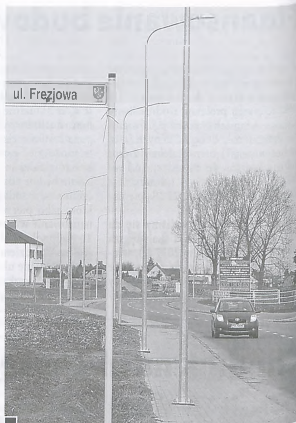
Rząd zamontowanych wiosną latarni ulicznych w części ul. Polnej. Wyraźnie widać jak dodana infrastruktura rozmięka się z istniejącą linią chodnika. Na pierwszym planie najbardziej wysunięta w ciąg chodnika latarnia w pobliżu ul. Frezjowej fot. Piotr P. Ruszkowski
