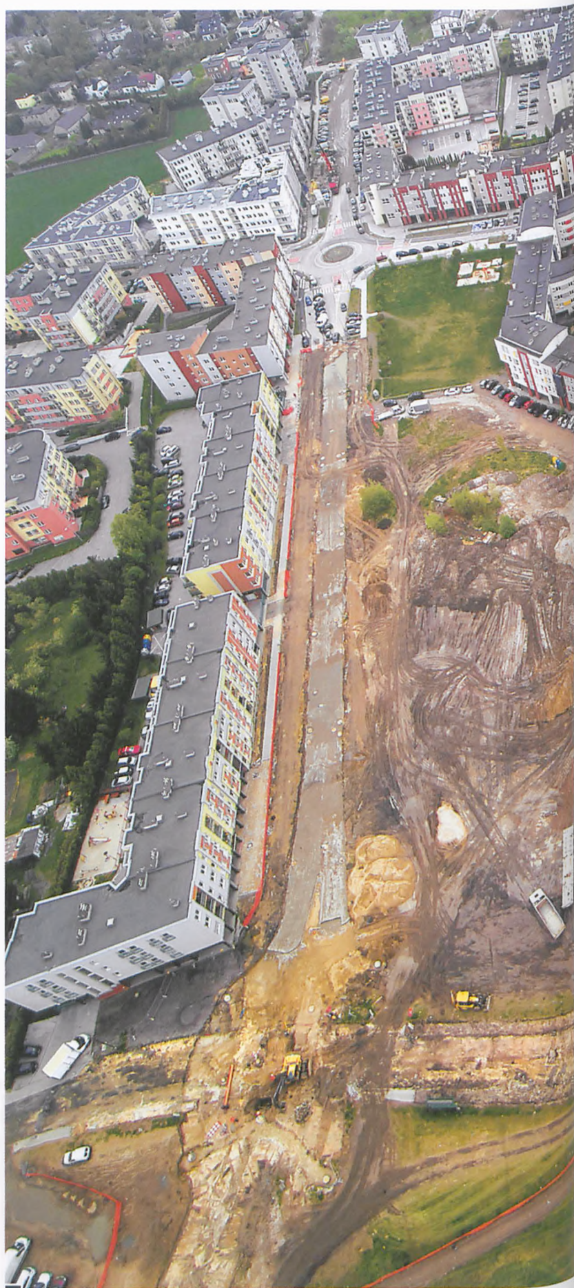
Zdjęcie wykonane z lotu ptaka – na 1. planie, u dołu, trwają prace przy budowie ronda na skrzyżowaniu al. Jana Pawła II z ul. Pułaskiego. Dalej, w górę, widzimy częściowo wykonany chodnik po stronie bloków z adresem: al. Jana Pawła II 7 i 9 oraz koryto przyszłej jezdni; następnie gotowe rondo na ul. Wschodniej (wykonane w ub. roku). Kolejny odcinek – w kierunku ul. Konarzewskiego – na którym trzeba wykonać dodatkowo oświetlenie uliczne (zastawiony jeszcze przez urządzenia budujące blok przy ul. Wschodniej 26) fot. Rafał Wojtyński
