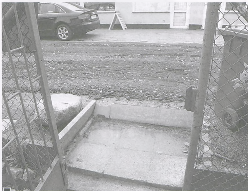
Wykonane wcześniej przez mieszkańców zabezpieczenia przed zalaniem posesji, po nawiezieniu kruszywa do utwardzenia drogi, na nic się teraz zdadzą
