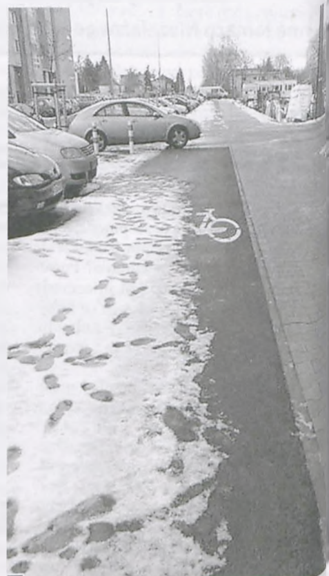
Asfaltowej, nowo powstałej ścieżki rowerowej w Nowym Centrum Lubonia nikt nie sprząta fot. Edmund Świniarek
