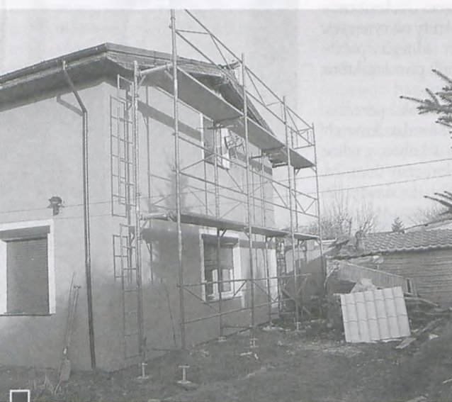
Całoroczny dom na działkach przy ul. Świerczewskiej – naprawa części konstrukcji dachowej fot. Hanna Siatka
