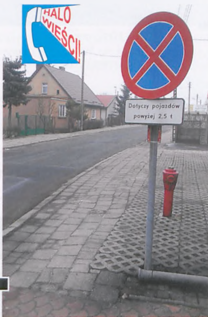
Znak drogowy na ul. 3 Maja zawieszony 38 centymetrów poniżej normy, na wysokości 162 cm fot. Piotr P. Ruszkowski
