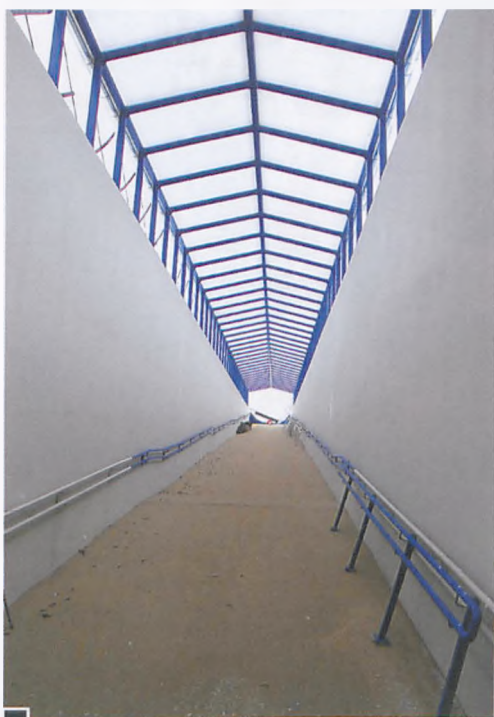
Prawie gotowy zadaszony podjazd dla wózków i rowerów prowadzący z tunelu w kierunku dworca fot. Piotr P. Ruskowski
