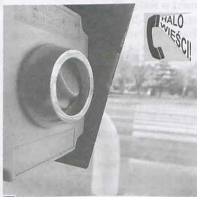
Po raz kolejny uszkodzony przycisk sygnalizacji świetlnej na ul. Żabikowskiej w okolicy Pułaskiego fot. Hanna Siatka
