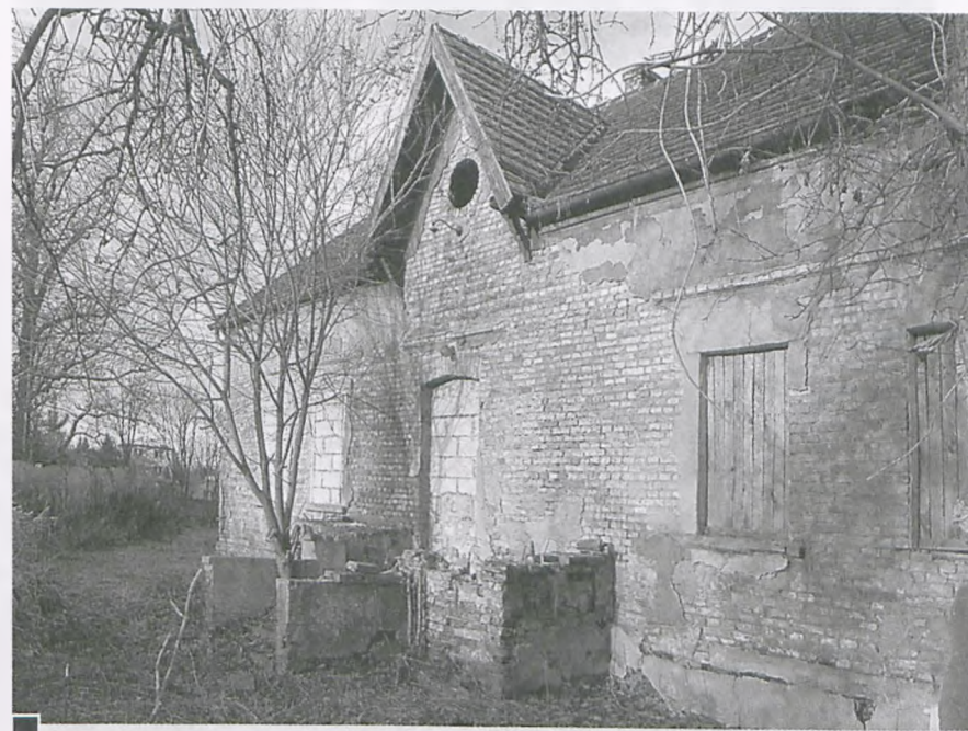
Ruiny historycznego Domu Włodarza z dawnego folwarku Augusta hr. Cieszkowskiego położony w głębi przy ul. Powstańców Wlkp. fot. Piotr P. Ruszkowski
