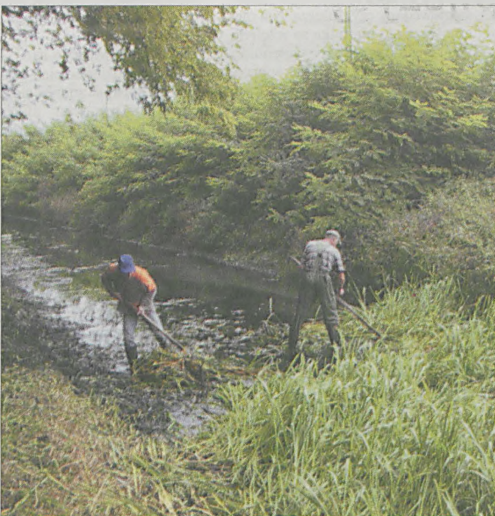
Prace na Kanale Kąkolewskim prowadzone w ramach programu „Rowy”
