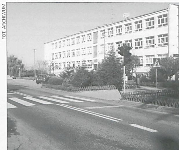
Bezpieczna droga do szkoły, wykonano sygnalizację i przejście z mas chemoutwardzalnych (rok 2001)
