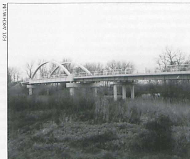
Remont mostu na Noteci w Białosławiu (droga nr 190, rok 2000)
