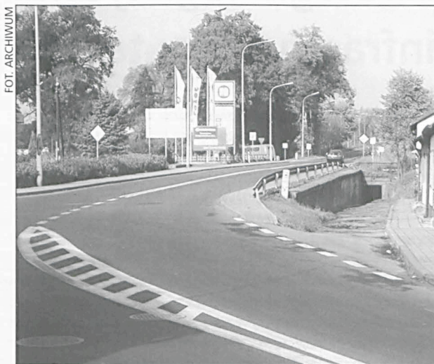
Remont drogi nr 178 w Czarnkowie
