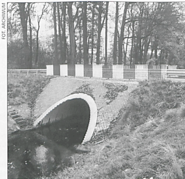
Przebudowany na przepust most w Przebudowie, droga nr 187
