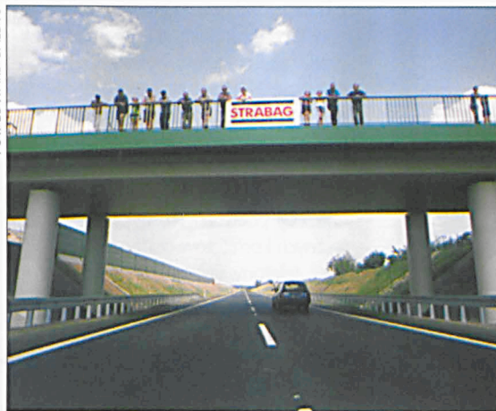
Jeden z trzech żelbetonowych wiaduktów
