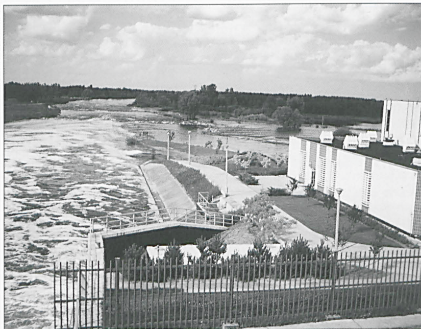
Jeziorsko; dolne stanowisko jazu.
