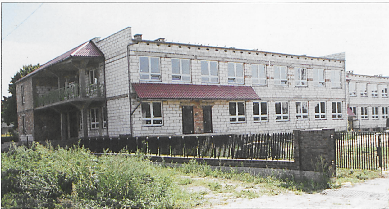
Za rok do użytku oddana zostanie nowoczesna szkoła zawodowa - największa obecnie inwestycja w powiecie.
