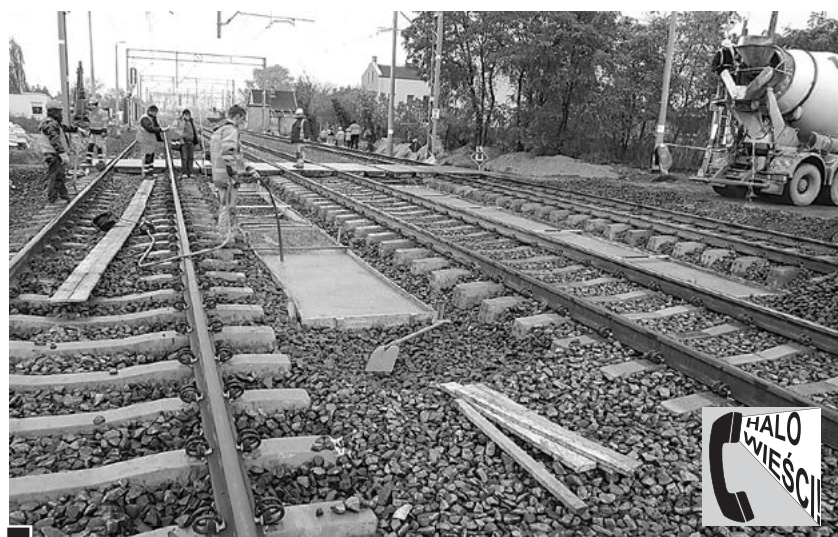
Wylewanie umocnień pod przyszłym przejazdem kolejowym w rejonie Zakładów Ziemniaczanych fot. Piotr P. Ruszkowski
