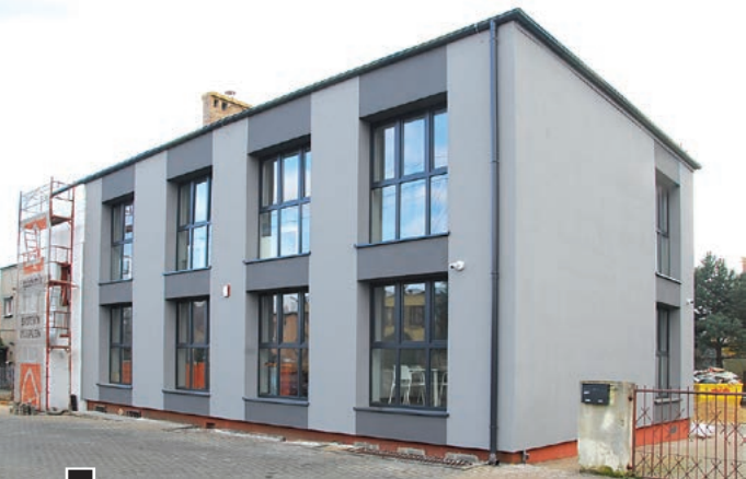
Były budynek Inspektoratu PZU przy ul. Powstańców Wielkopolskich, obecnie siedziba DWD. Po wymianie stolarki drzwiowej i okiennej, trwają tu prace termoizolacyjne oraz elewacyjne fot. Piotr P. Ruszkowski
