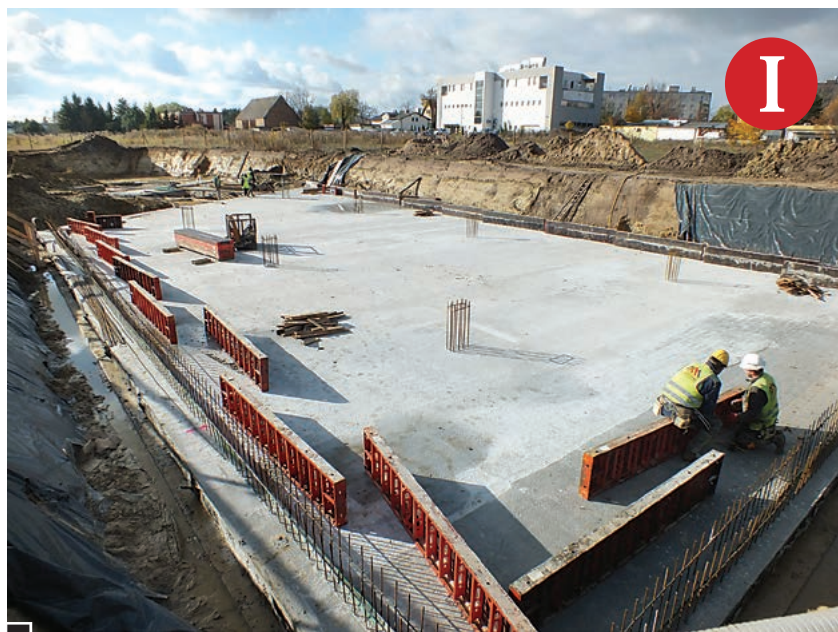
Fundamenty budynku oraz garażu podziemnego stawianego przez firmę M45 przy al. Jana Pawła II, przy tylnym wjeździe na rynek fot. Hanna Siatka
