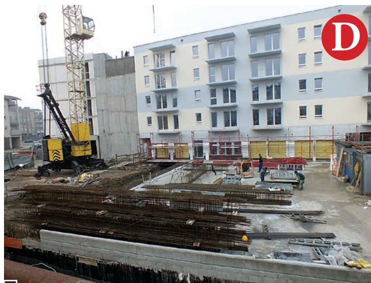
Blok z podziemną halą garażową przy ul. Wschodniej 26 od strony al. Jana Pawła II 15 – w budowie; pierwszy fragment już otynkowany fot. Hanna Siatka
