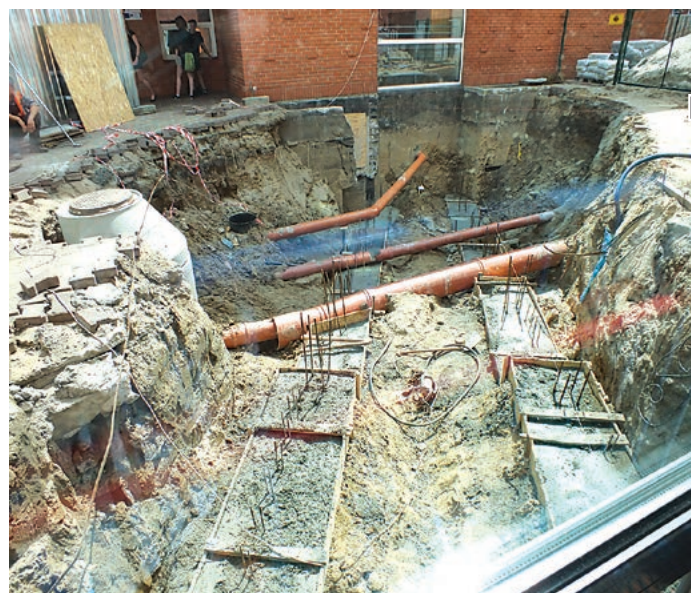
W wykopie pod przyszły łącznik pomiędzy Gimnazjum nr 2 (w głębi) a LOSIR-em widoczne fundamenty, przez które będzie przechodzić istniejąca infrastruktura fot. Hanna Siatka
