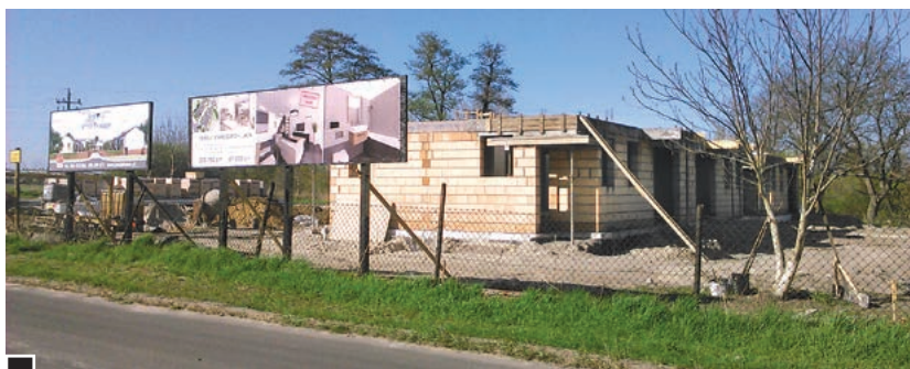
Wznoszące się mury budynków osiedla „Stare Ogrody” przy ul. Ogrodowej i Cyklamenowej fot. Paulina Sawicka
