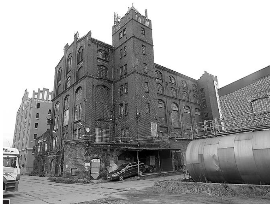
Zdjęcie sondażowe – zabytkowe budynki Zakładów Ziemniaczanych. Dziś obiekty prywatne. Na pierwszym planie centralnie Drożdżownia wybudowana w 1904 r. (należy do firmy „Lubanta”), tuż za nią – oczyszczona budowla z jasnej cegły – to słodownia (należy do Marka Zimlińskiego), z prawej niski budynek z malowanymi fugami, za cysterną, to druga drożdżownia z 1906 r., późniejsza melasownia. Wszystko powstało w ramach firmy G. Sinnera fot. Filip Wesołowski
