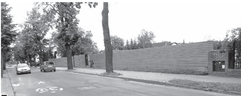
Na posesji przy ul. Poniatowskiego 46, na której wcześniej stał jeden dom z niemieckiej kolonii z początku XX wieku, powstanie 11 budynków. Na tablicy informacyjnej, która zawisała w czasie, gdy Urząd Miasta przygotowywał odpowiedź na list, podano: „budynek jednorodzinny dwulokalowy”; „budynek jednorodzinny dwulokalowy w zabudowie bliźniaczej” fot. Hanna Siatka
