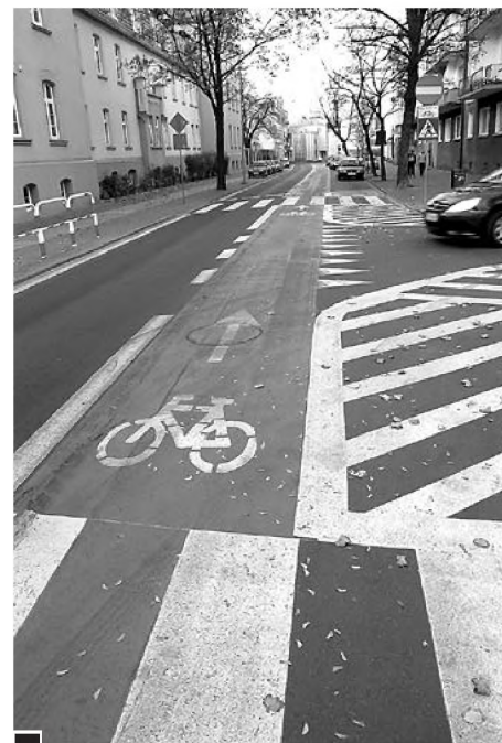
Przykład czytelnego układu komunikacyjnego w Ostrowie Wlkp. z wyraźnie wydzielonym na jezdni parkingiem i kontrapasem dla rowerów, dodatkowo wyróżnionym czerwonym kolorem fot. Piotr P. Ruszkowski
