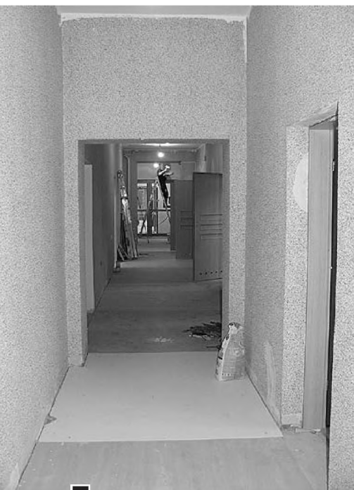
W lokalu trwają prace remontowo-adaptacyjne fot. Paweł Wolniewicz
