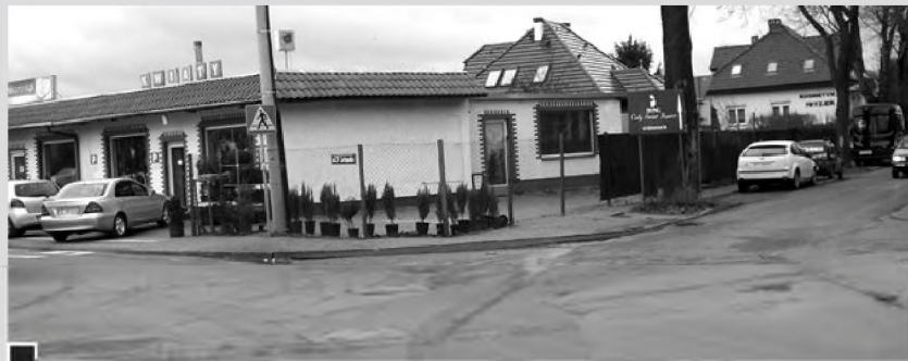
Tuż za ogrodzeniem stała do niedawna, doklejona do obiektu widocznego na zdjęciu, budowla sprzeczna z miejscowymi planami zagospodarowania miasta fot. Hanna Siatka
