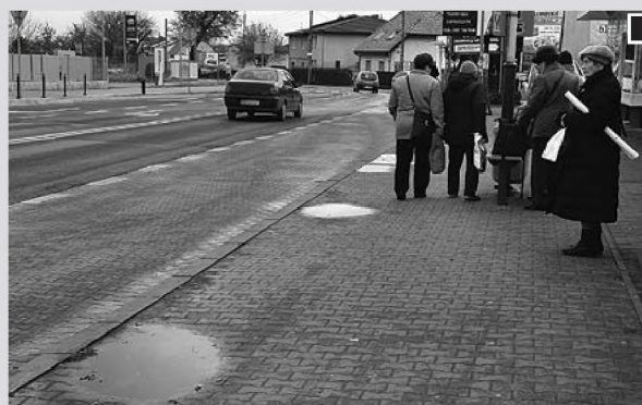
Niezadaszony przystanek autobusowy, z którego korzysta wiele osób. Dodatkowym mankamentem są zagłębienia w chodniku. Pasażerowie sygnalizują, że często drzwi autobusu przypadają w miejscach, gdzie tworzą się kałuże fot. Piotr P. Ruszkowski
