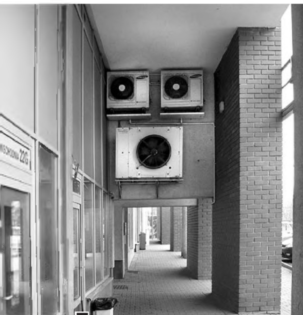
Jeden z powodów nieznośnych drgań, które przenoszą się na mieszkania położone powyżej fot. Jerzy Nowacki
