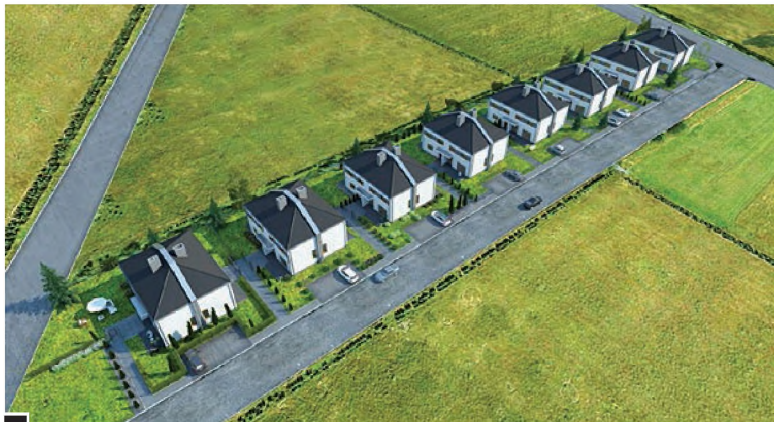
Rzut z góry na powstający kompleks nowoczesnych budynków. Z prawej w głębi ul. Polna
