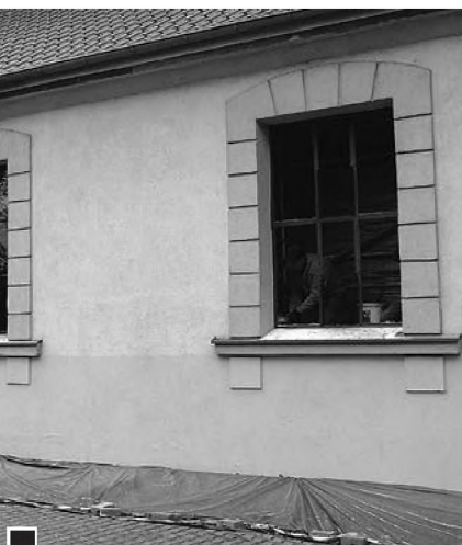
Jeszcze przed nadejściem zimy wstawiono nowe, funkcjonalne i szczelne okna fot. Paweł Wolniewicz
