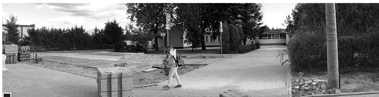
Nowy parking przed szkołą, zapewniający 10 miejsc parkingowych, w tym 3 dla osób niepełnosprawnych fot. Agata Samol
