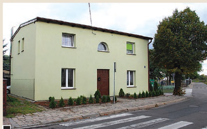
Dawny dom gminny – lokalny zabytek starego Lubonia został ocieplony i odnowiony fot. Piotr P. Ruszkowski
