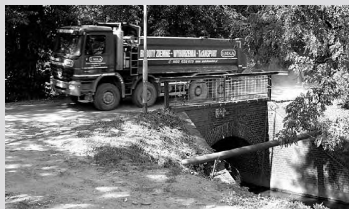
Czteroosiowa wywrotka marki MAN, załadowana tonami betonowego gruzu i ziemi, przyjeżdżająca przez coraz bardziej „zmęczony” most. Za nią, w tumanach pyłu i kurzu, przechodzący deptakiem ludzie fot. Paweł Wolniewicz
