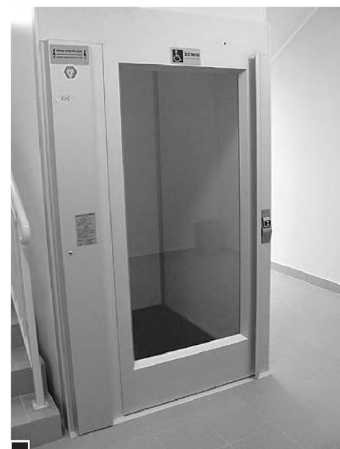
Z myślą o osobach niepełnosprawnych w budowanym skrzydle zamontowano specjalną windę fot. Paweł Wolniewicz
