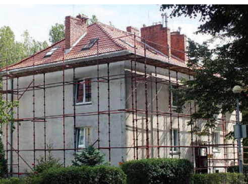
Budynek SM „Swarzędz” przy ul. Kolonia PZNF 7 pokryty nową dachówką fot. Hanna Siatka
