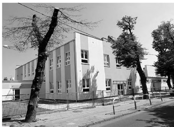
Nowy segment Szkoły Podstawowej nr 1 – widok od ul. Szkolnej fot. Jan Błaszczak
