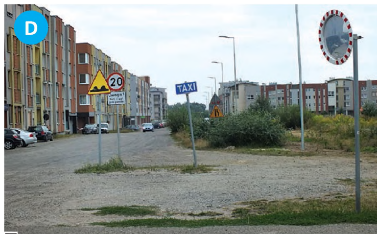
Bałagan informacyjno-komunikacyjny przy wjeździe na główną drogę NCL (al. Jana Pawła II od ul. Pułaskiego) – w bliskim sąsiedztwie 2 znaki drogowe (w tym jeden z postawionych tego lata na drogach gruntowych w Luboniu znak ograniczenia prędkości do 20 km/godz. z sugestią, by jechać jeszcze wolniej), tabliczka wskazująca na miejsce postoju taksówek (bodaj jedyne w 30-tysięcznym mieście – w stanie żalnym) oraz lustro drogowe fot. Hanna Siatka
