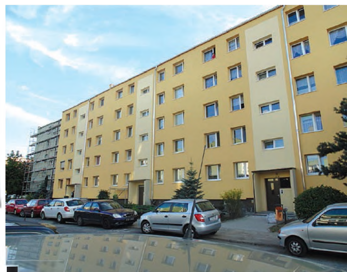
Nowa elewacja bloku przy ul. Sikorskiego 31 fot. Jan Błaszczak
