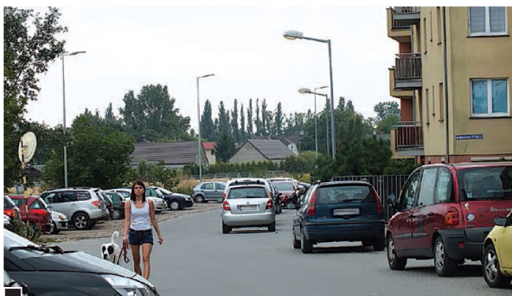
Tłok komunikacyjny na odcinku ul. Wschodniej skracającej w kierunku ul. Pułaskiego. Lampy po obu stronach drogi, po lewej – nowe, zainstalowane przez miasto (i lustro na wprost wyjazdu z osiedla), po prawej – oświetlenie zamontowane przed laty przez dewelopera. Na zdjęciu nie widać zasłoniętych zielenią, niższych, kulistych latarni ustawionych od strony chodnika w przyblokowych ogródkach fot. Hanna Siatka
