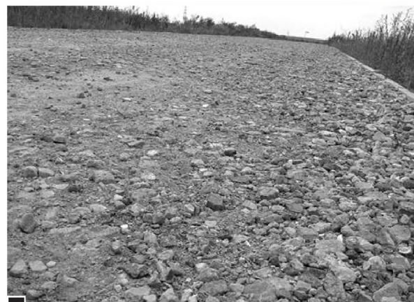
Drogę dojazdową do osiedla (ul. Kujawska – boczna od gruntowej ul. Buczka) deweloper utwardził materiałem z kruszarni gruzu. Wielu mieszkańców starych, gruntowych dróg w Luboniu życzyłoby sobie chociaż takiej nawierzchni fot. Anna Pinkowska
