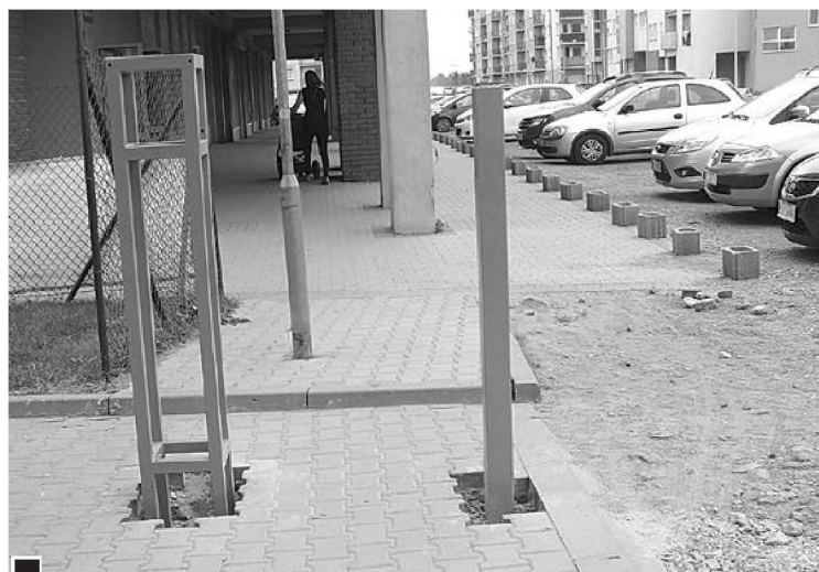
Konstrukcja nowo budowanego ogrodzenia wmontowana w dotychczasowy chodnik fot. Hanna Siatka
