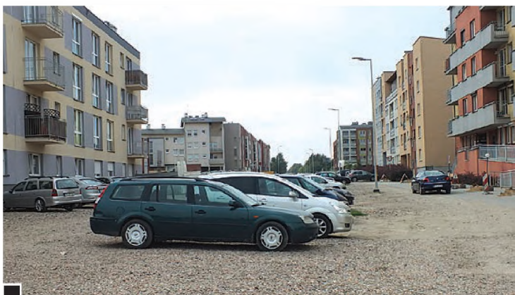
Nowa rzeczywistość w miejscu urwanej inwestycji – ul. Wschodniej od strony ul. Okrzei. Zgodnie z projektem (patrz „WL” 11-2013, str. 12), jezdnia będzie miała szerokość 6 m. Samochody stoją w pasie jezdni, zamiast z prawej strony, gdzie kierowcy wciąż używają wyłożonego kostką przez dewelopera pasa wcześniejszej drogi fot. Hanna Siatka
