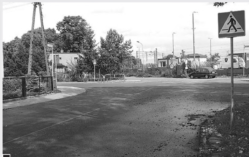
Znak przejścia dla pieszych powinien być ustawiony bezpośrednio przed przejściem. Pasów brak, możemy więc się jedynie domyślać, że w tym miejscu bezpiecznie przedostaniemy się na drugą stronę ul. Cieszkowskiego fot. Agata Samol
