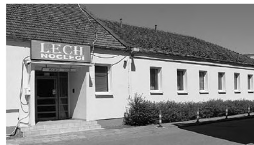
Budynek dawnego hotelu pracowniczego Zakładów Chemicznych, ostatnio hotel „Lech” – pomieszczenia na Warsztaty Terapii Zajęciowej „Wspólnej Drogi” fot. AS
