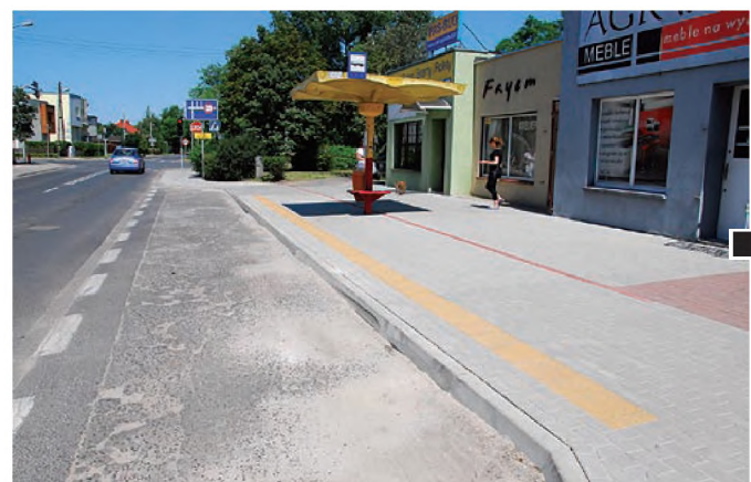
Odnowiony i podniesiony krawężnik przystanku autobusowego przy ul. ks. Streicha fot. Piotr P. Ruszkowski
