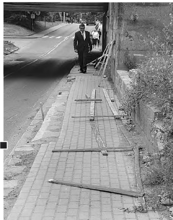
Niedzielne popołudnie ok. godz. 14 – wyłamane barierki tarasujące chodnik pod wiaduktem na ul. Powstańców Wlkp. fot. Piotr P. Ruszkowski
