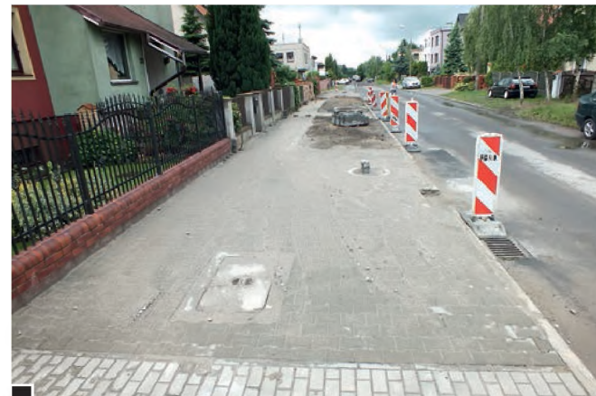
Projekt przewiduje utwardzenie chodnika przy granicy z posesjami i we wjazdach. W tym miejscu kostkę położono do samej jezdni fot. Hanna Siatka
