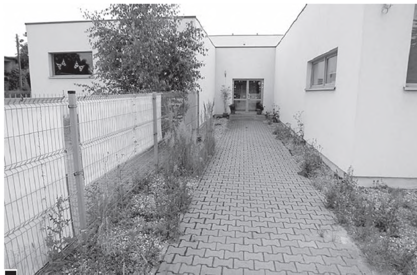
Zarośnięty teren przed bocznym wejściem do przedszkola od ul. Klonowej (główne znajduje się od ul. Miodowej) fot. Hanna Siatka
