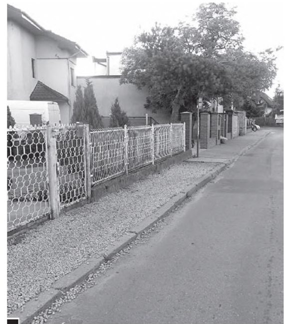
Nieprzyjazny chodnik i brak siedziska na przystanku przy ul. Traugutta
