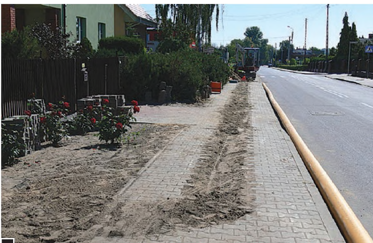
Nowy, plastikowy gazociąg na ul. Fabrycznej montowany w chodniku fot. Agata Samol
