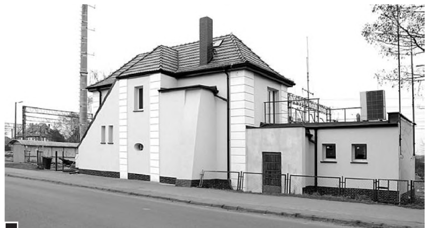
Odremontowany budynek nastawni i dróznika PKP przy ul. Dworcowej, naprzeciw wylotu ul. Fabrycznej fot. Piotr P. Ruszkowski
