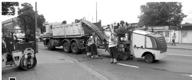
Prace na ul. Żabikowskiej (frezowanie nawierzchni) na wysokości SP 2 i OSP fot. Władysław Szczepaniak
