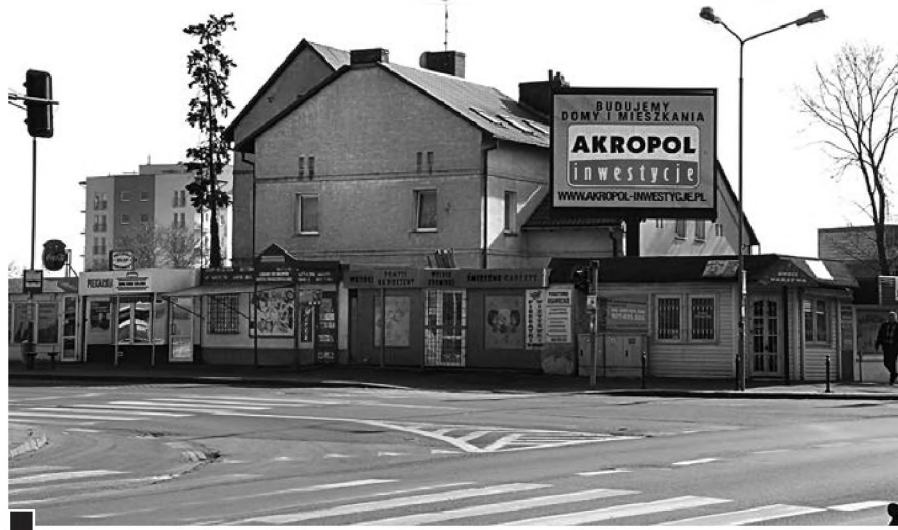
Billboard na ruchliwym skrzyżowaniu ul. Żabikowskiej i Powstańców Wlkp. jest budowlą nielegalną i zakłóca percepcję architektury zabytkowego budynku fot. Piotr P. Ruszkowski
