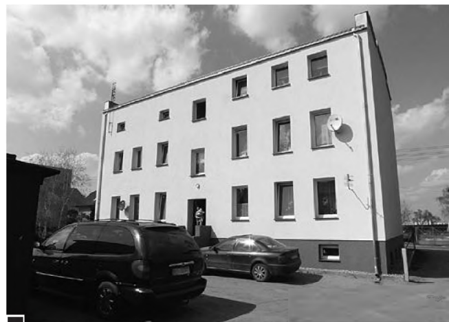
Odremontowany gruntownie budynek komunalny przy ul. Łącznej 4 – widok od strony podwórza fot. Hanna Siatka
