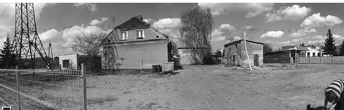
Miejska nieruchomość przy ul. Armii Poznań 111 – w głębi z lewej widoczny budynek z mieszkaniami komunalnym i socjalnymi, obok z prawej – nie rozebrany jeszcze ostatni budynek gospodarczy. Wygląda na to, że teren przygotowano na sprzedaż. Optymalne przeznaczenie – budowa domu jednorodzinnego fot. Hanna Siatka
