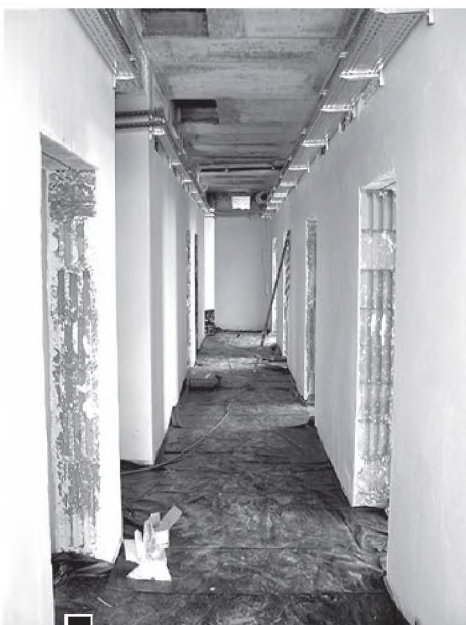
Na piętrze wykonano stosowne instalacje oraz położono tynki i posadzki wewnętrzne fot. Paweł Wolniewicz
