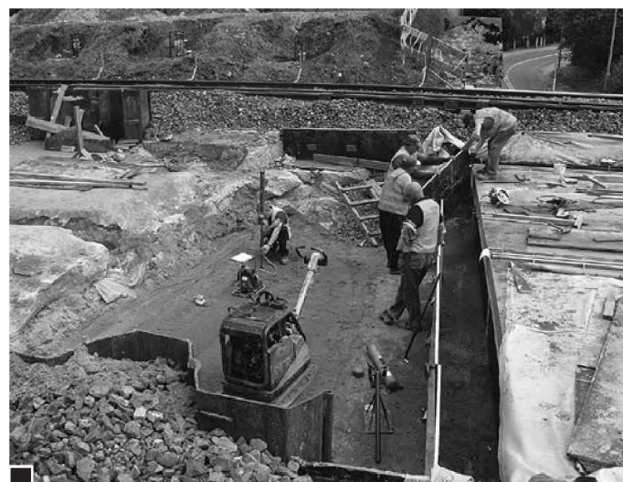
Prace dylatacyjne na wiadukcie kolejowym przy ul. Powstańców Wielkopolskich fot. Paweł Wolniewicz
