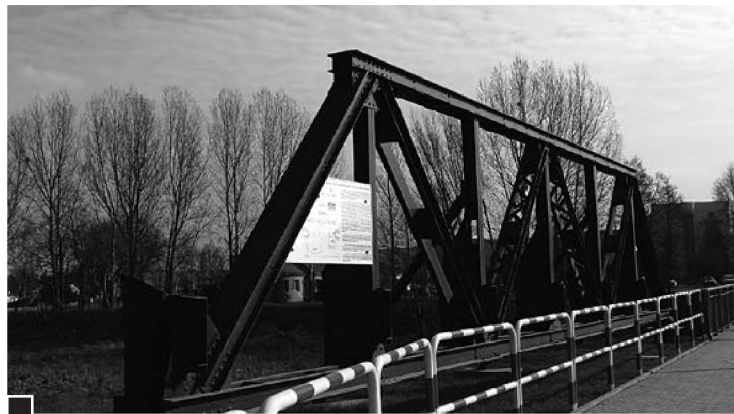
Przesło zabytkowego mostu wkomponowane w konstrukcję nowego dla upamiętnienia historii fot. Agata Samol
