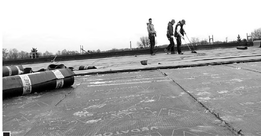
Po ociepleniu dachu położono na nim trwałą papę termozgrzewalną fot. Paweł Wolniewicz
