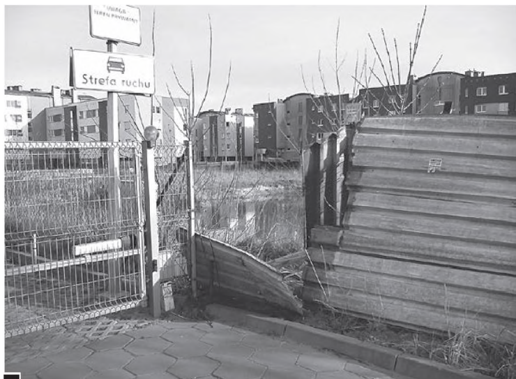
Dziura w ogrodzeniu, a za nim niebezpieczny wykop w śliskiej glinie, pełen wody fot. Beata Stempczyńska
