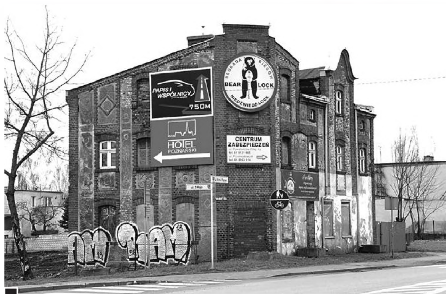
Liczący 112 lat dom rodziny Hernesów, w narożniku budynku, pod tablicą „Centrum Zabezpieczeń” portal zamurowanych drzwi prowadzących dawniej do gospody i sklepu rzeźnickiego. Widoczne istniejące drzwi od strony ul. Armii Poznań to wtórne wejście do powojennego sklepu GS, a następnie sklepu spożywczego. Wewnątrz znajduje się jeszcze oryginalny wystrój m.in. płytek ceramicznych z początku XX wieku. Widoczna po prawej stronie brama umożliwiająca wejście i wjazd na podwórze gospodarza fot. Paweł Wolniewicz
