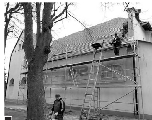
Ostatnie roboty na remontowanym dachu sanktuarium fot. Hanna Siatka
