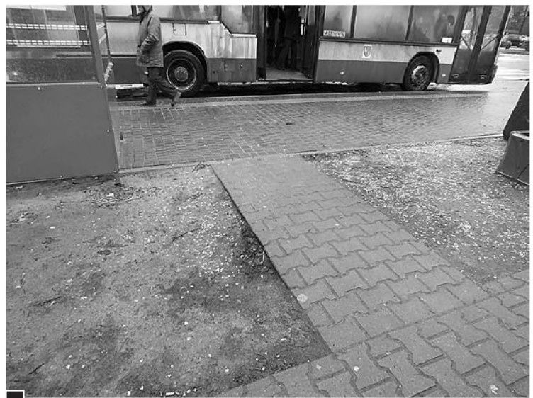
Wąskie przejście do przystanku, wykonane z myślą wyłącznie o poruszających się o własnych siłach. Jeśli koło wózka zjedzie z pozbruku, pojazd straci stabilność i może się przewrócić. W głębi widać różnicę wysokości pomiędzy niedawno wykonanym krawężnikiem zatoki autobusowej a wejściem do niskopodłogowego pojazdu. Bez specjalnej platformy wózek inwalidzki nie wjedzie do środka fot. Hanna Siatka
