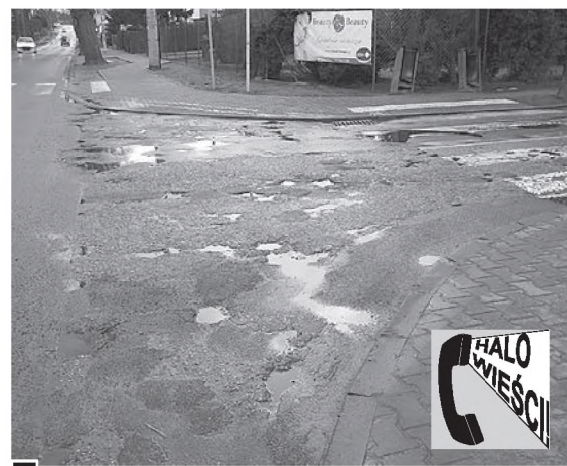
Efekt wielokrotnego łatania wyłotu ul. Lipowej w Poniatowskiego fot. Hanna Siatka
