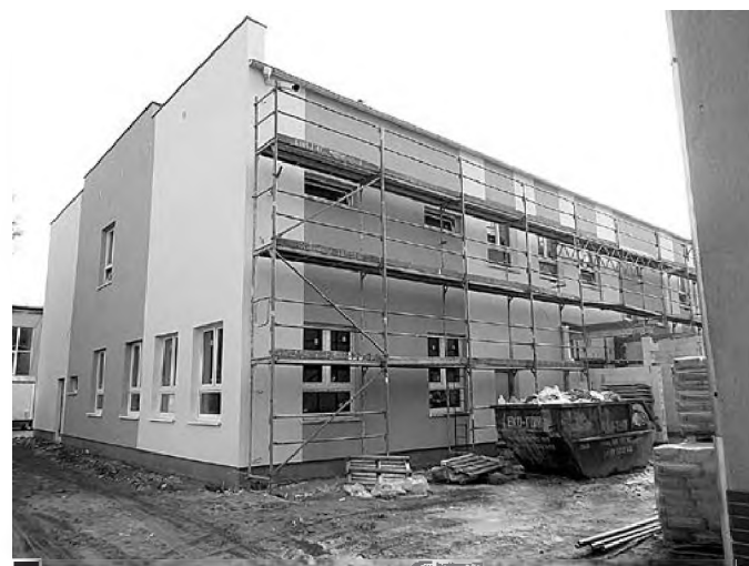
Kładzenie zewnętrznych tynków na nowym segmencie SP 1 – budynki zyskuje ostateczną formę architektoniczną fot. arch. UML
