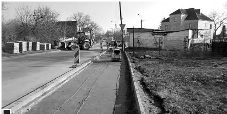
Po budowie kanałów deszczowego i sanitarnego w ul. 1 Maja przystąpiono do wykonania chodników fot. arch. UML
