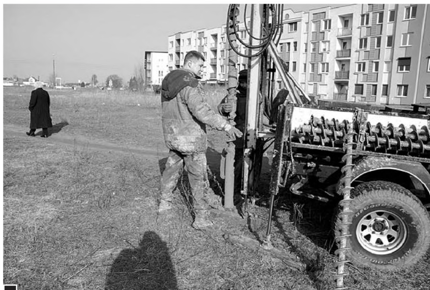
Odwierty na niezagospodarowanym klinie pomiędzy al. Jana Pawła II, ul. A. Mizerki i Pułaskiego przeprowadzane 20 lutego fot. Piotr P. Ruszkowski
