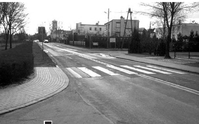
Kawałek chodnika wykonano też na ul. Puszkina przy dojściu do placu zabaw fot. arch. UML
