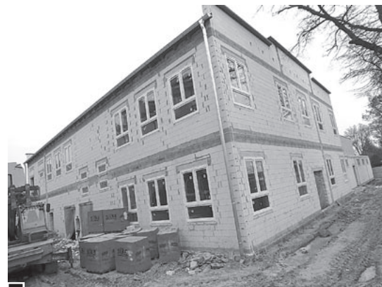
Nowy segment Szkoły Podstawowej nr 1 wraz z łącznikiem do sali gimnastycznej, zgodnie z planem, jest już w stanie surowym zamkniętym. Trwają prace instalacyjne wewnątrz budynku fot. Hanna Siatka
