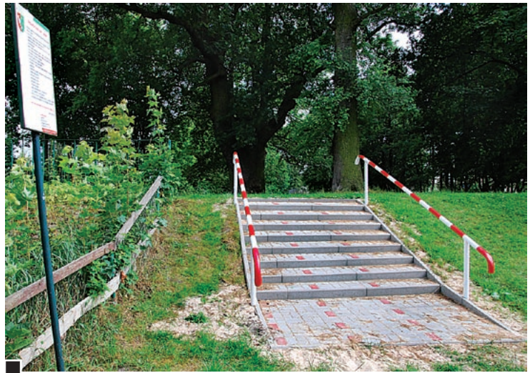
Pomimo wielu interwencji, korzystający z placu zabaw przy ul. Puszkina nie doczekali się przyjaznego zjazdu dla wózków. Trzeba je wciągać po schodach lub po trawiastej skarpcie fot. Piotr P. Ruskowski
