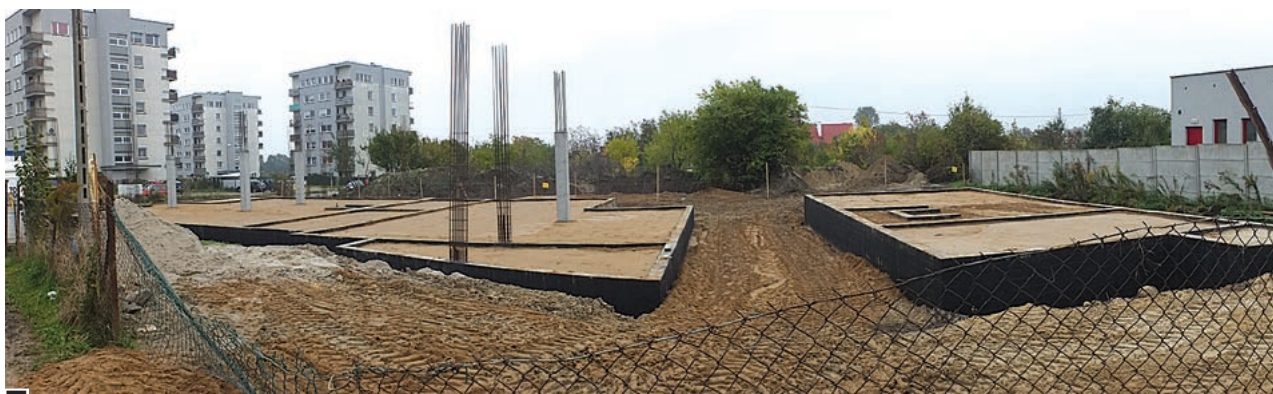
Fundamenty nowej lubońskiej poradni medycznej i przedszkola. Pomiędzy oddzielnymi budynkami powstanie łącznik. W większym (z lewej) będą przychodnia i przedszkole, w mniejszym prawdopodobnie magazyn fot. Hanna Siatka
