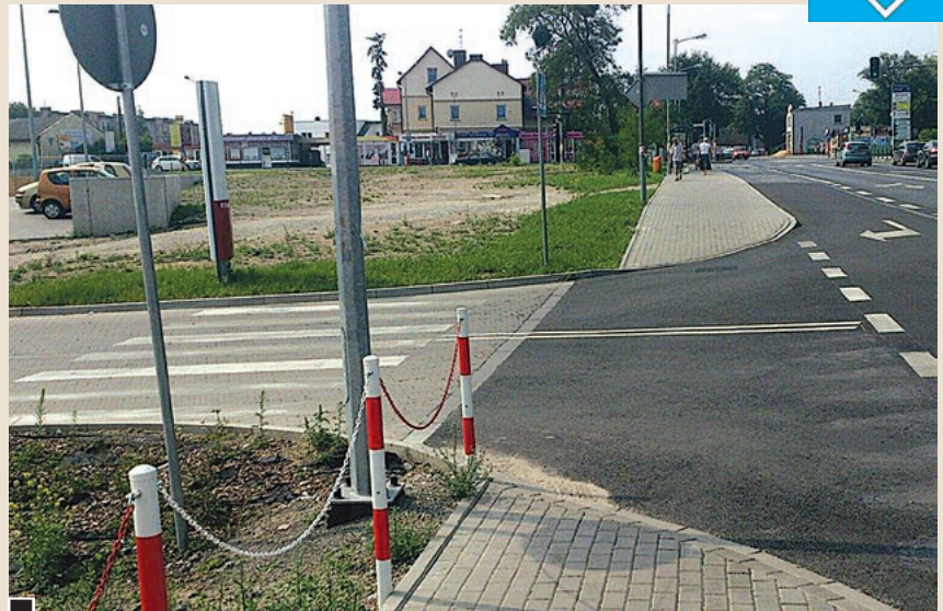
Nowe oznakowanie przy Intermarché – dla kogo? Problem już sygnalizowaliśmy. Pasy dla pieszych pomalowano, a logicznego przejścia, dojścia, zejścia... nadal nie ma fot. Adam Beim
