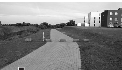
Zbudowany wzdłuż Strumienia Junikowskiego i dalej Warty pierwszy odcinek drogi spacerowo-rowerowej od strony ul. 3 Maja jest dobrym i optymalnym rozwiązaniem – nie psujemy tego przez wprowadzenie tu ruchu zmotoryzowanego – uszanujmy tę wartość! fot. Piotr P. Ruszkowski
