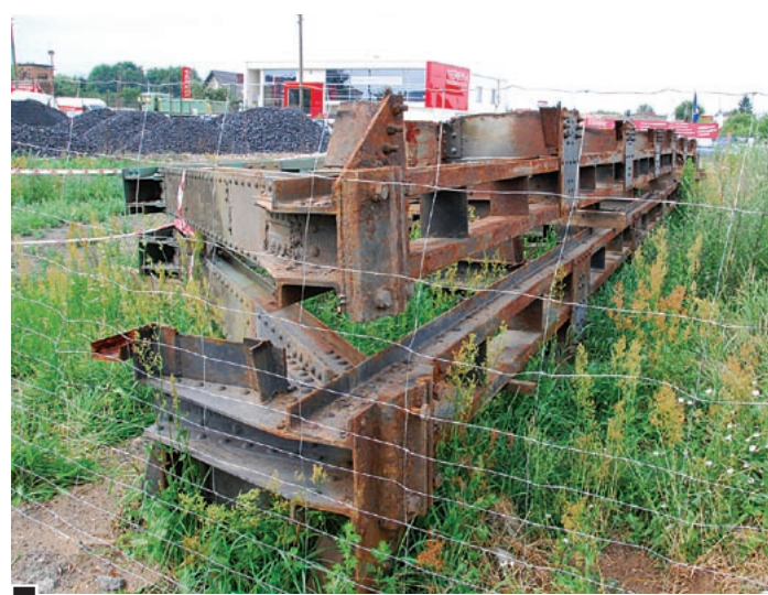
Przechowywane przy ul. Sobieskiego (w tle, po drugiej stronie drogi, restauracja Verona) około 17-metrowe przęsła zabytkowego mostu, które przed montażem w nowych miejscach zostaną oczyszczone przez piaskowanie i dokładnie zabezpieczone przed korozją fot. Piotr P. Ruszkowski
