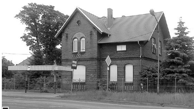
Dom, w którym mieszkają państwo Baranowsky. „Po kompleksowym remoncie dachu, małżeństwo rozpoczęło krucjatę przeciwko mnie” fot. Marcin Dzierżawczyk
