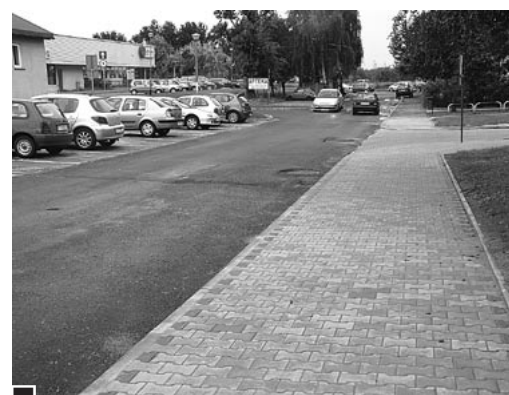
Odremonowany fragment chodnika na ul. Sikorskiego na wysokości Banku WBK, uczęszczany przez mieszkańców osiedla „Lubonianka” i klientów pobliskiego sklepu „Bierdonka”. Prace, na zlecenie miasta, wykonała firma „Kom-Lub” fot. Hanna Siatka
