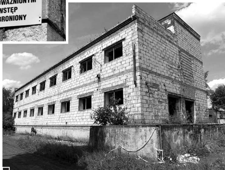
Stan techniczny budynku jest dobry. Nie ma spękań, ubytków i uszkodzeń konstrukcyjnych. PINB nakazał rozbiórkę ze względu na zaniedbanie i niebezpieczeństwo zaistnienia wypadku oraz brak nadzoru nad obiektem fot. Hanna Siatka
