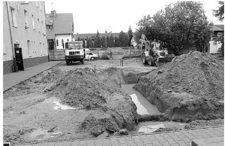
Boisko szkolne SP 1 zamienione w plac budowy. Rurę widoczną w wykopie pod fundament nowego segmentu trzeba było przełożyć w inne miejsce fot. Hanna Siatka
