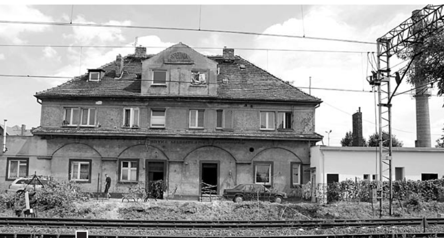
Budynek dawnej marmoladowni przy ul. Armii Poznań 78 (dziś mieszkania Spółdzielni Mieszkaniowej o tej samej nazwie – „Spójnia”). Widok przez tory kolejowe od strony ul. Dworcowej (odstłonięty dzięki wycięciu drzew przy okazji modernizacji torowisk Poznań-Wrocław) fot. Piotr P. Ruskowski
