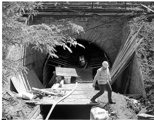
Burmistrz M. Tomaszuk lustruje prace remontowe prowadzone przez PKP przy przepuście nad Strumieniem Junikowskim przy ul. Dworcowej
