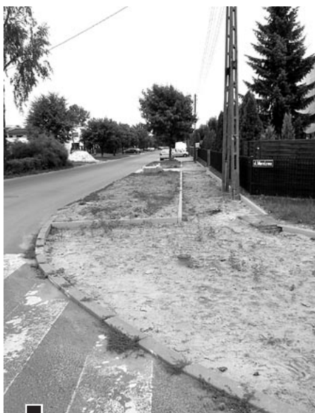
Wykonawca chodnika na ul. Morelowej opuścił plac budowy. Choć ma jeszcze czas, by wywiązać się z umowy, nie wiadomo, czy tam powróci fot. Hanna Siatka
