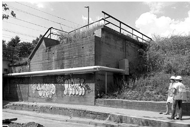
Małgorzata Machalska przy remontowanym wiadukcie na ul. Powstańców Wlkp.
