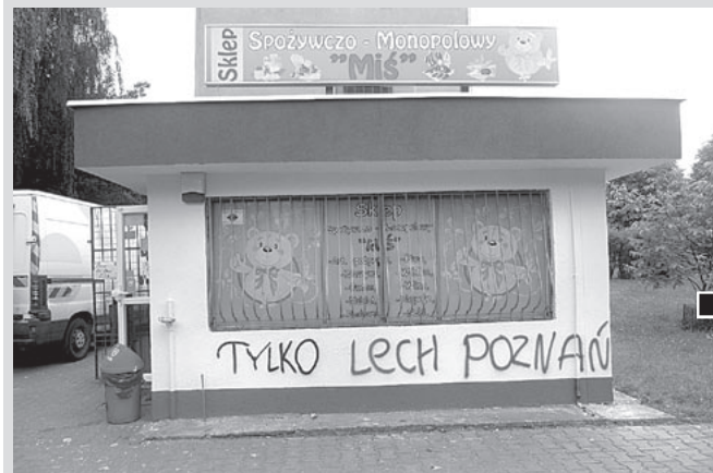
Świeżo odnowioną elewację sklepu wandalizm oszpecili sprayem fot. Władysław Szczepaniak
