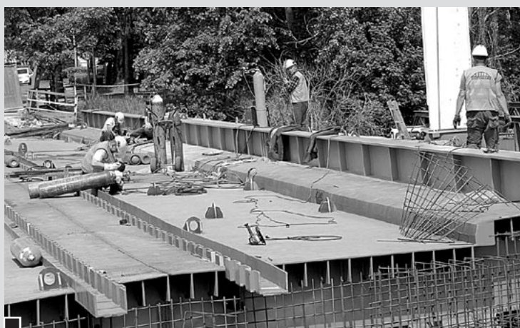
Montaż nowego stalowego mostu prowadzącego do Luveny (stan z 5 czerwca) fot. Piotr P. Ruszkowski
