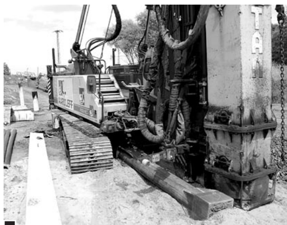
Specjalny kafar do wbijania betonowych pali pod przyszły wiadukt, pracuje tuż za południową granicą miasta fot. Piotr P. Ruszkowski
