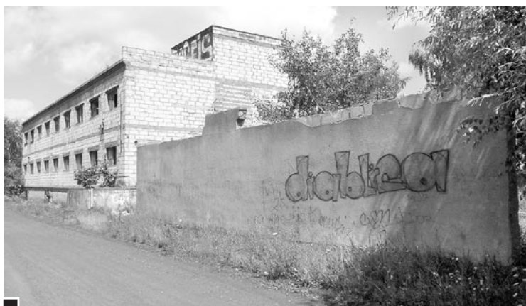
Zdewastowany obiekt po firmie „Intersmak” przy ul. Zielonej 46 (przy drodze prowadzącej z placu E. Bojanowskiego na cmentarz żabikowski i do ROD „Chemik”). Według Miejscowego Planu Zagospodarowania Przestrzennego „Żabikowo-Północ” teren przeznaczony jest pod usługi fot. Hanna Siatka
