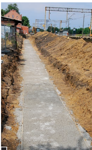
Fundamenty pod przyszłe ekrany dźwiękochłonne przy dworcu od strony ul. Dworcowej fot. Piotr P. Ruszkowski
