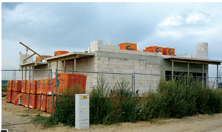
Prace się w górę mury kolejnego budynku, w którym będzie 12 mieszkań fot. Paulina Sawicka
