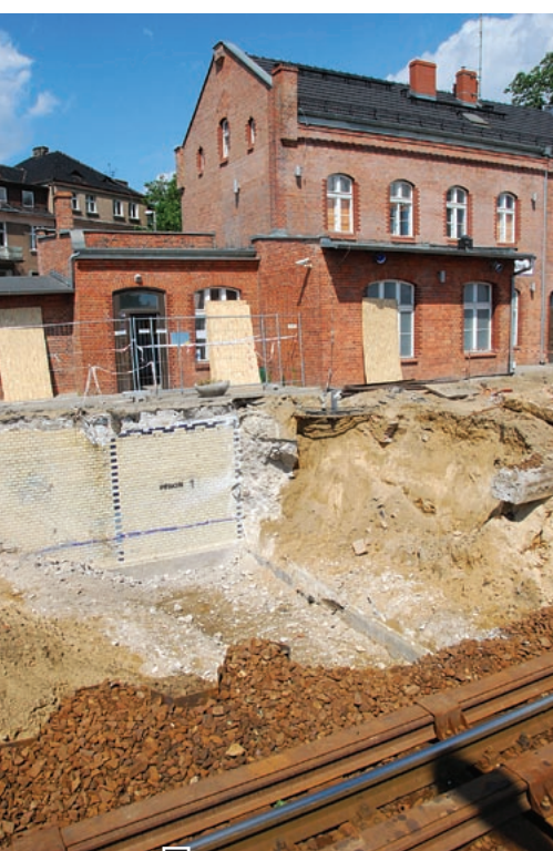
Dziura po rozbiórce starego tunelu, w tle budynek lubońskiego dworca fot. Piotr P. Ruszkowski
