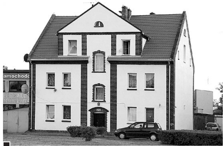
Odrestaurowany ostatnio zabytkowy dom mieszkalny przy ul. Dworcowej 10 należący do Spółdzielni Mieszkaniowej „Spójnia” z nową dachówką oraz odnowioną elewacją fot. Piotr P. Ruszkowski
