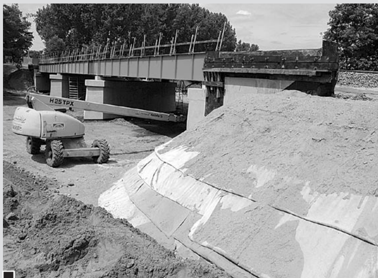
Krótszy o dwa 17-metrowe przęsła od poprzedniego, nowy most Luveny – widok od strony Zakładów (stan z 5 lipca) fot. Piotr P. Ruszkowski
