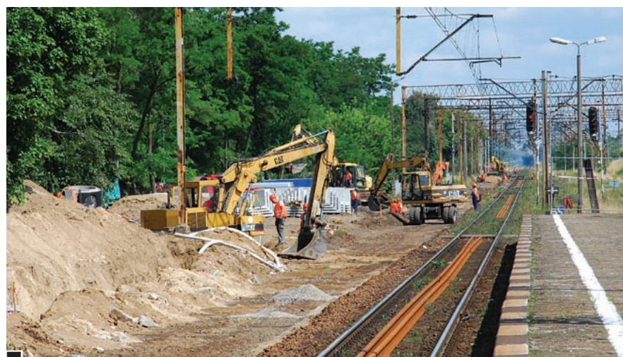
Na wysokości deptaku ul. Dworcowej trwają prace przy odtwarzaniu nowoczesnego torowiska i budowie nowego, dłuższego peronu w europejskim standardzie fot. Piotr P. Ruszkowski
