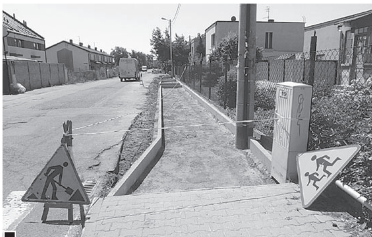
Rozpoczęto budowę chodnika na ul. Klonowej fot. Hanna Siatka
