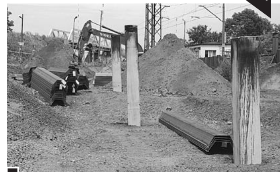
Betonowe pale pod przyszły wiadukt wbite w grunt tuż za przejazdem kolejowym na granicy Lubonia w Łęczycy. W tle z lewej widać wiadukt kolejowy torowiska na trasie do Wolsztyna, z prawej budkę dróżnika przy przejeździe kolejowym fot. Piotr P. Ruszkowski
