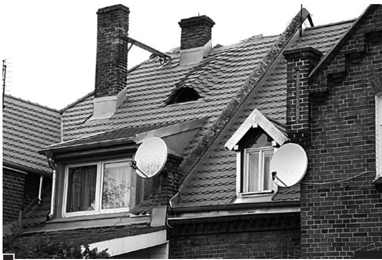
Dach jednego z domów osiedla przy ul. Cyryla Ratajskiego, na którym ostatnio wymieniono pokrycie. Warto też zwrócić uwagę na detale pozostawione w zabytkowych dachach fot. Piotr P. Ruszkowski
