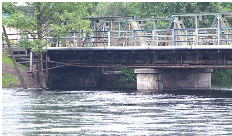
To samo przeszło podczas ostatniej powodzi – 2010 r. (por. „WL” 06-2010 str. 25). Czy podjęcie tego tematu, to wytwarzanie irracjonalnego strachu, jaki zarzucali mi rozmówcy z ramienia inwestora? Jedni twierdzą, że ograniczenie dotychczasowego przepływu pod mostem o 2/5 zwiększa zagrożenie powodziowe, inni, uważają, że zmieni się jedynie energia kinetyczna przepływu (prędkość) nie wysokość fot. Piotr P. Ruszkowski
