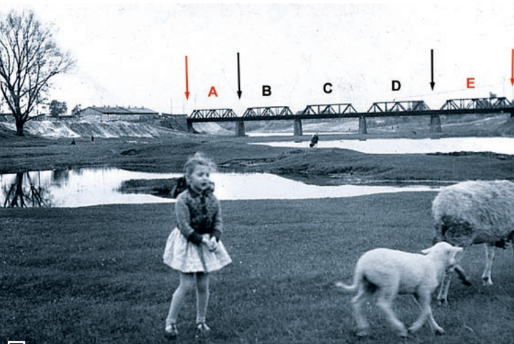
Jedno z archiwalnych zdjęć (lata 50. XX w.), na którym w całej okazałości z tyłu widać pięcioprzęsłowy most (pomiędzy czerwonymi strzałkami) w ul. Romana Maya prowadzący do Zakładów Chemicznych, wybudowany około 1910 r. Pomiędzy tak odkrytych przestrzeni (bez mułu i zarośli) najstarsi lubonianie z okolic pamiętają, jak podczas powodzi poziom wody był taki, że mogli moczyć nogi, siedząc na moście. Po lewej teren Zakładów Chemicznych. Dokładnie w stulecie uruchomienia produkcji (1914 r.), nowi właściciele fundują nowy, okrojony o przeszła „A” i „E”, most (pomiędzy czarnymi strzałkami)
