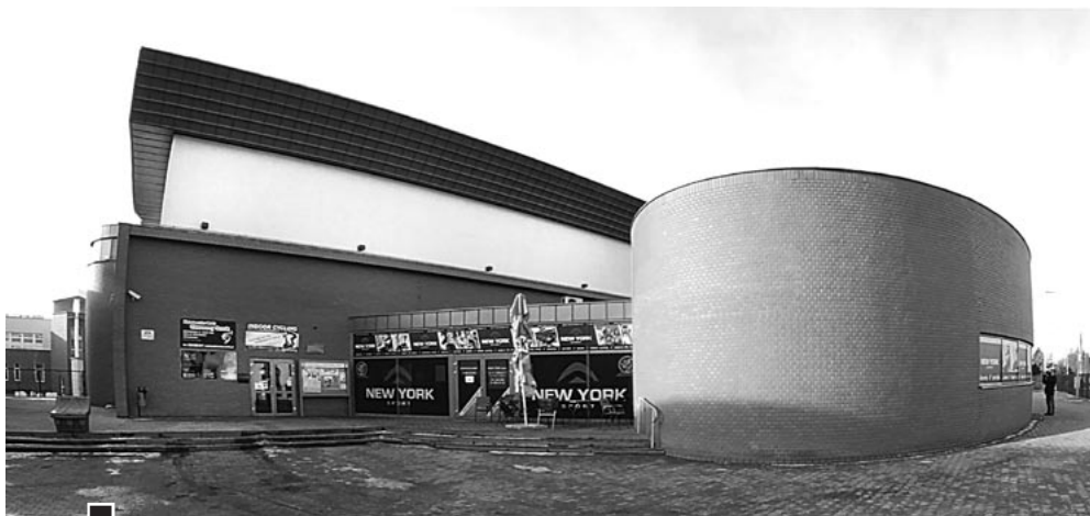
Hala widowiskowo-sportowa LOSiR przy ul. Kołtąta 2, przed nią owal New York Sport adaptowany przez prywatnego inwestora na siłownię i salę fitness z recepcją, wg kosztorysu za około 450 tys. zł (bez wyposażenia w sprzęt) fot. Piotr P. Ruszkowski
