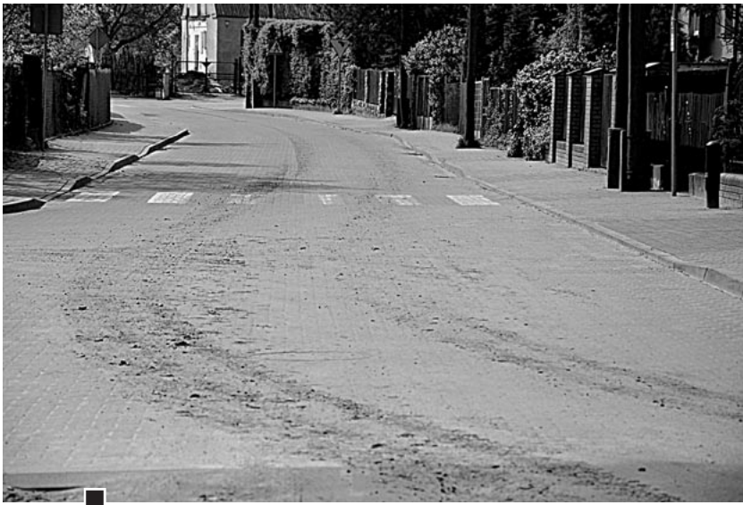
Ziemia nawieziona kołami ciężarówek na nawierzchnię ul. Broniewskiego fot. Piotr P. Ruzkowski
