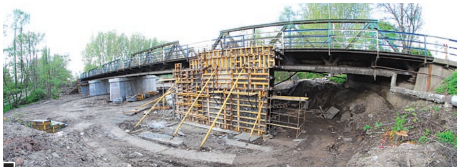
Widok od strony południowej przebudowywanego mostu prowadzącego do Luveny. Po prawej wschodnie przeszło, które zostanie zabudowane, zmniejszając prześwit przeznaczony dla występującej wody powodziowej. Podobna betonowa ściana powstaje po drugiej, zachodniej stronie fot. Piotr P. Ruszkowski
