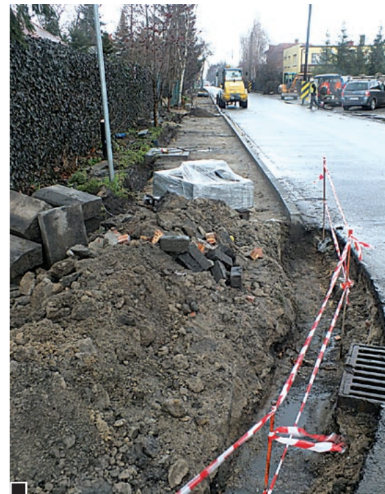
Na łuku przy gwiaździstym skrzyżowaniu z ul. Rejtana trzeba było rozebrać położony w 2009 r. krawężnik, przy którym zrobił się ściek, i wykonać głęboki wykop pod nowy fot. Hanna Siatka
