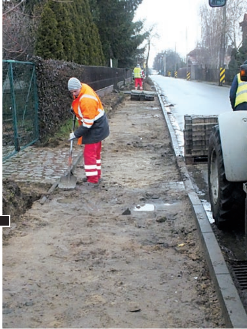
Na łuku przy gwiaździstym skrzyżowaniu z ul. Rejtana trzeba było rozebrać położony w 2009 r. krawężnik, przy którym zrobił się ściek, i wykonać głęboki wykop pod nowy fot. Hanna Siatka
