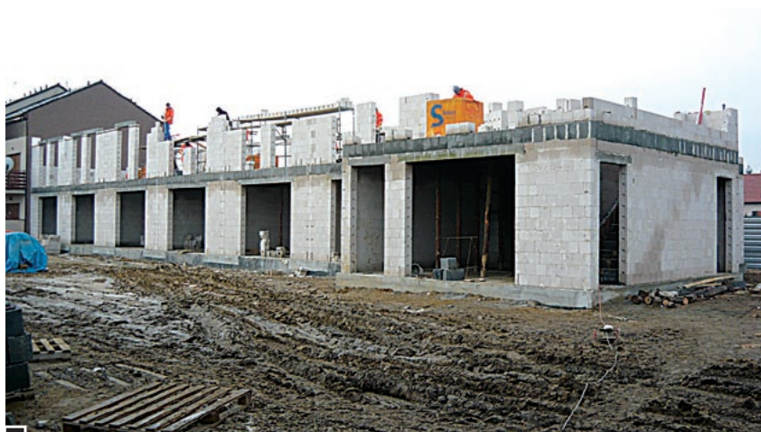
Budynki firmy „Tefra House” – stan budowy z 18 grudnia 2013 r. fot. Paulina Sawicka
