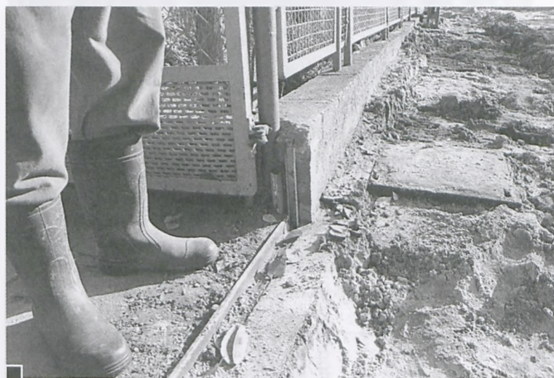
Mieszkańcy najniższej położonych posesji, borykający się z zalewaniem domostw podczas burz i nawałnic, opalali sposób obrony przed naporem wody, budując wysokie murki przy ogrodzeniach, a we wjazdach wstawiając specjalne blokady fot. Piotr P. Ruszkowski
