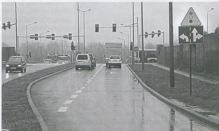
Na skrzyżowaniu ul. Dębieckiej z Armii Poznań brakuje drogowskazów. Najczęściej przyjeżdżni, jadący z Lubonia od strony CH Factory, gubią się, nie wiedząc, dokąd prowadzą poszczególne pasy jezdni. Wielu, nie mając informacji, jedzie prosto i dostając się na autostradę, klnie na lubońską organizację ruchu. Niewiele potrzeba, by to zmienić. Wystarczy na zielonym, prawym pasie postawić drogowskaz (zielona tablica) wskazujący trasy: w lewo – Poznań-Dąbiec, w prawo – Luboń-Mosina, na wprost – A2-Warszawa (niebieska tablica ze znakiem autostrady) fot. Piotr P. Ruszkowski
