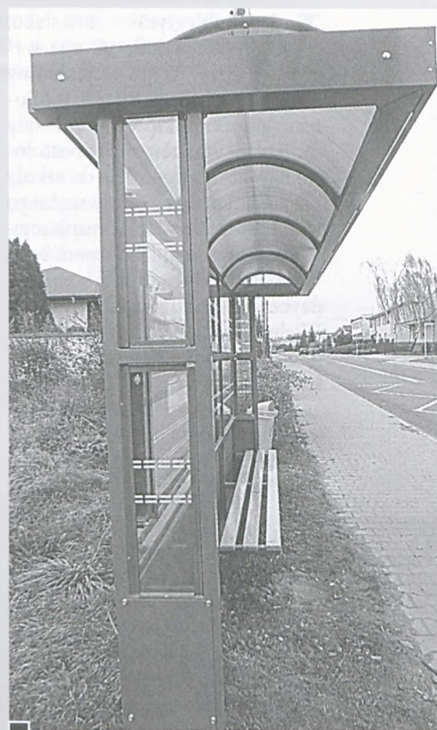
Przykład nowej wiaty przy ul. Fabrycznej naprzeciw przychodni „Med-Lux”. Zbyt wąskie: daszek (1 m szeroki) i ścianki boczne (27 cm szerokości) nie chronią przed deszczem i wiatrem fot. Hanna Siatka
