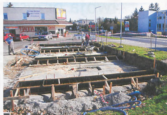
Prace przy budowie myjni przy rondzie, prowadzone na poziomym gruncie bezpośrednio przy pasie zieleni oddzielającym od chodnika fot. Piotr P. Ruszkowski
