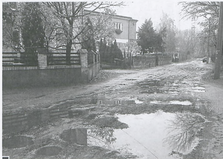
Niewielki odcinek na przedłużeniu asfaltowej ul. Dąbrowskiego za ul. 3 Maja (równoległy do płotu stadionu) już dawno miał być utwardzony. Pieniądze na roboty zebrali, a ulicy nie utwardzili. Tak wygląda po niewielkich opadach deszczu fot. Marta Pniewska
