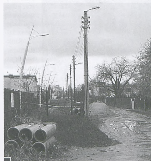
Firma TAR-DROG z Tarnowa Podgórnego buduje ulice Westerplatte, Świerkową i Wrzowską wraz z chodnikami i wjazdami na posesje. Przy okazji wykonana zostanie też kanalizacja deszczowa. Na zdjęciu ul. Westerplatte od ul. Kołtątaja. Widoczne na środku drogi słupy energetyczne zostaną niebawem usunięte. Kabel już położono w ziemi. Z lewej – nowe lampy fot. Hanna Siatka
