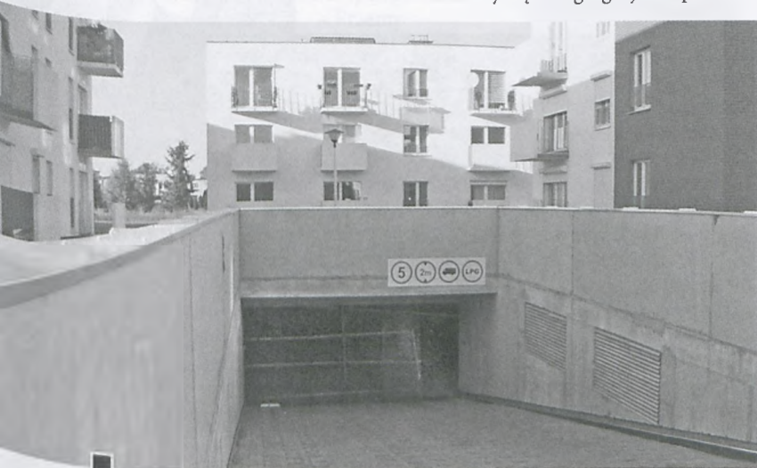
Wjazd do hali garażowej, która według obietnic pracownicy Pajo miała być otwarta do połowy października fot. Katarzyna Polerowicz-Kelma
