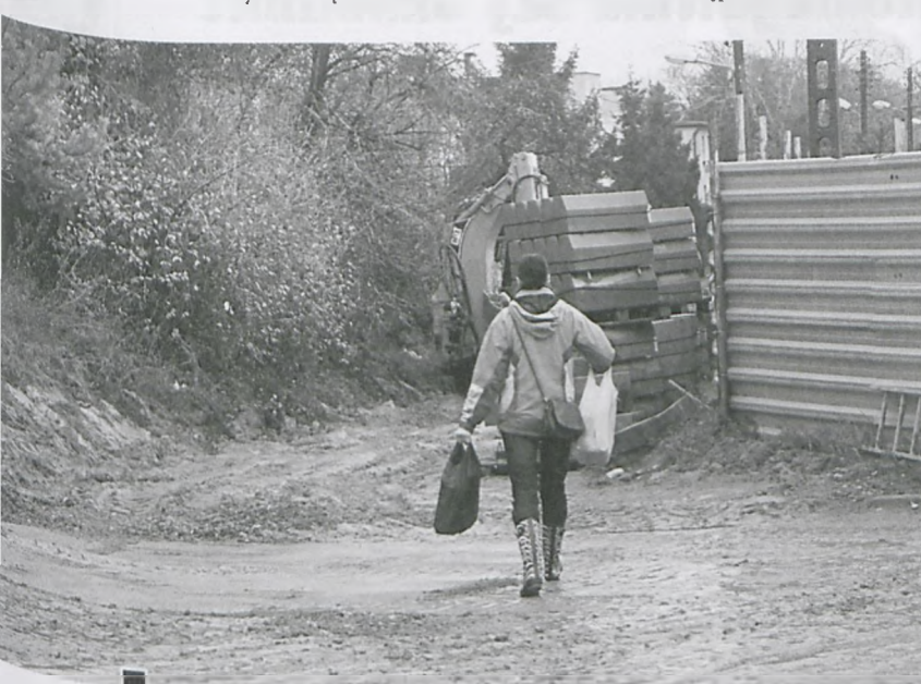
Żeby dojść do domów mieszkańcy muszą pokonać błoto po kostki i przemknąć pomiędzy pracującym sprzętem – widok ul. Paderewskiego od ul. Żabikowskiej (okolice Pajo Centrum). Na pocieszenie można powiedzieć, że po zakończeniu prac widoczna z lewej skarpa zniknie, w jej miejscu stanie żelbetowy mur oporowy, a po obu stronach asfaltowej drogi będą szerokie na 2-3 metry chodniki fot. Hanna Siatka
