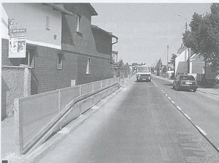
Na pierwszym planie ciąg 9 tarcz o szerokości 2 m opartych o barierę uderzeniową, chroniących nie tylko dom, ale też przechodniów przed potrąceniem i ochłapaniem przez samochody; dalej słupki amortyzujący ewentualne uderzenie samochodu w narożnik domu; w głębi kolejne 3 ekrany ochronne fot. Paweł Wolniewicz
