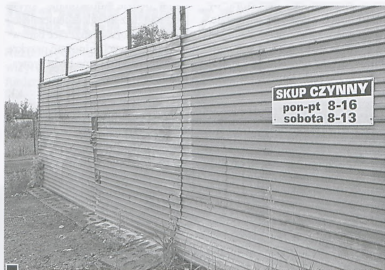
Wysoki, szczelny płot z blachy zabezpieczony dodatkowo drutem kolczastym, za którym nic ciekawego – tylko lub aż śmieci! Pomimo informacji, że skup czynny od poniedziałku do piątku w godzinach 8-16 oraz soboty od 8 do 13, na nikogo nie natrafiliśmy fot. Piotr P. Ruszkowski
