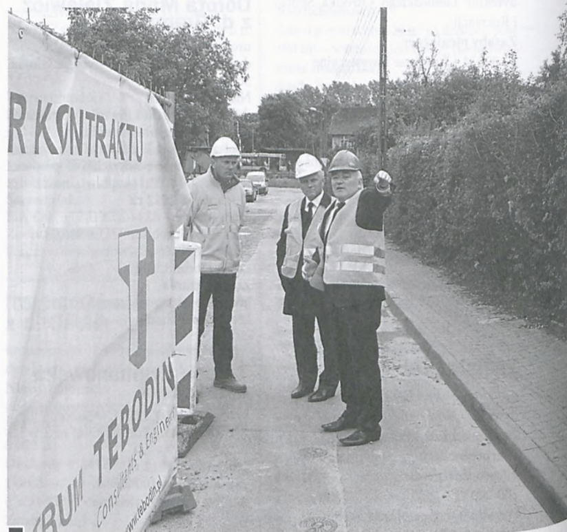
Na placu budowy, na ul. Walki Młodych – burmistrz Dariusz Szmyt (z prawej) i kierownik budowy Krystian Stuba (z lewej) zapoznają europośła z charakterem i przebiegiem inwestycji fot. Paweł Wolniewicz
