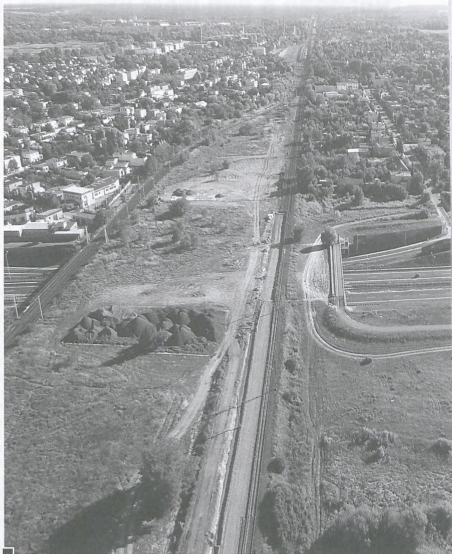
Widok na miejsce, gdzie trwają roboty przy modernizacji torowiska linii E59 na tunelu autostradowym na granicy Lubonia. Z góry dobrze widać hałdy tłucznia różnej wielkości (z lewej). Wyraźnie widać zdemontowany wschodni tor nad tunelem i w kierunku Poznania. W dole autostrada i ul. Dębiecka oraz (z prawej) ul. Rivoliego fot. Rafał Wojtyniak
