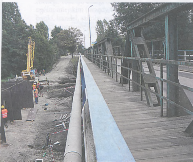
Obok zabytkowego mostu z lewej widać prace związane z modernizacją obiektu fot. Paulina Sawicka
