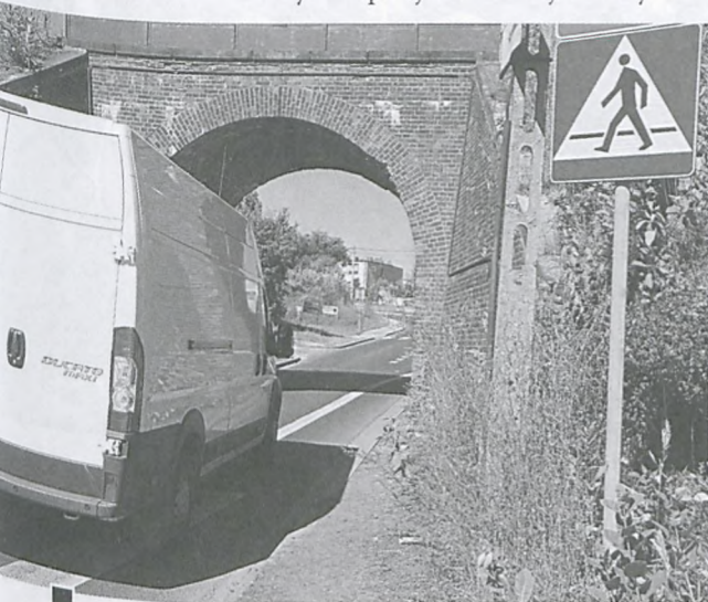
Wydzielone linią przejście dla pieszych pod wiaduktem na ul. Krętej, po którym bez przeszkód jeżdżą samochody. Przejechał np. wózek dziecięcy czy inwalidzki tego miejsca wymaga siły i nie lada zręczności. Pokonać bowiem trzeba kilka (3 do 6 razy) wysokich krawężników, wyboisty pojeźdż oraz jezdnię razem z samochodami fot. Piotr P. Ruszkowski
