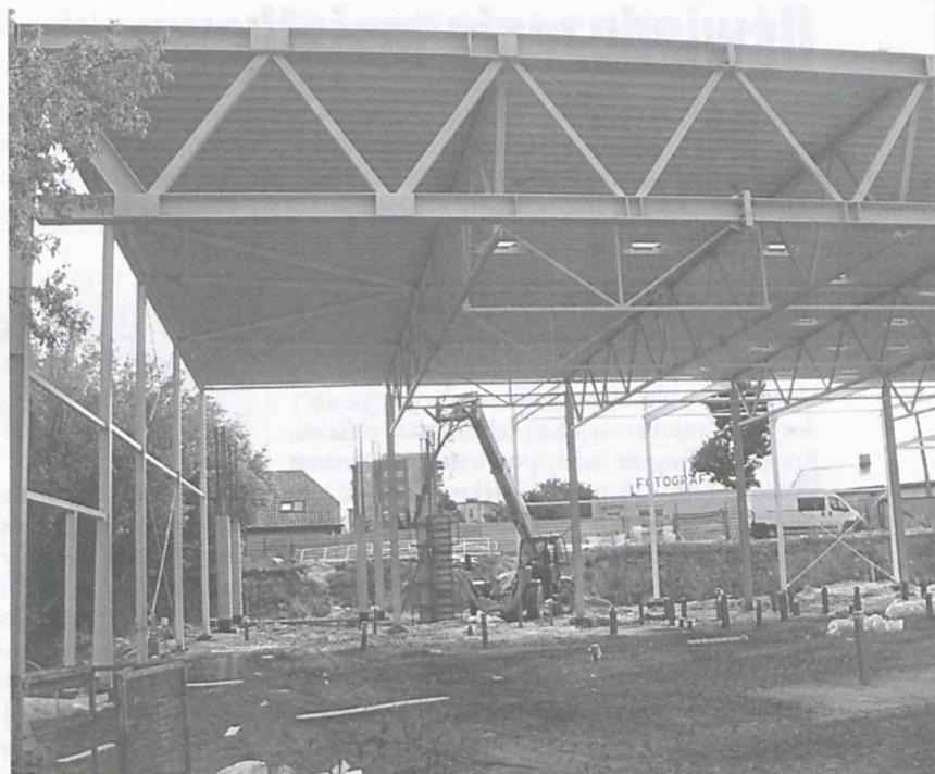
Konstrukcja powstającego supermarketu. W głębi o ok. 3 m wyżej – ul. Powstańców Wlkp. i zakład fotograficzny, gdzie w przyszłości będzie wylot al. Jana Pawła II fot. Paweł Wolniewicz
