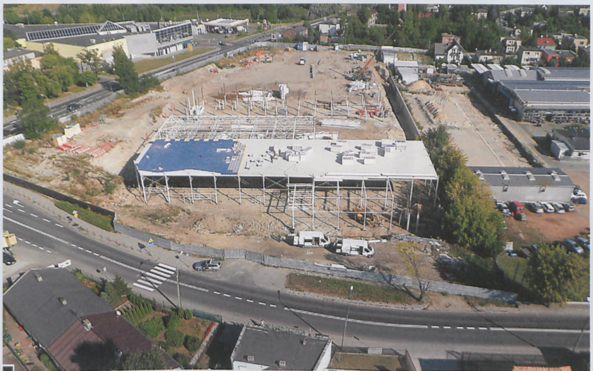
Plac budowy widziany z góry. U dołu widoczna ul. Powstańców Wielkopolskich, z lewej Pajo Centrum i ul. Żabikowska fot. Rafał Wojtyński
