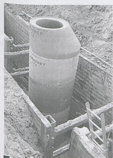
Kolektor wirski w ul. Dworcowej przebiega na głębokości ponad 6,5 m. Studzienki kładzie się obecnie do istniejącego poziomu gruntu w tym miejscu. Przyszła jezdnia ul. Dworcowej wytyczona jest ok. 1 m niżej fot. Piotr P. Ruszkowski
