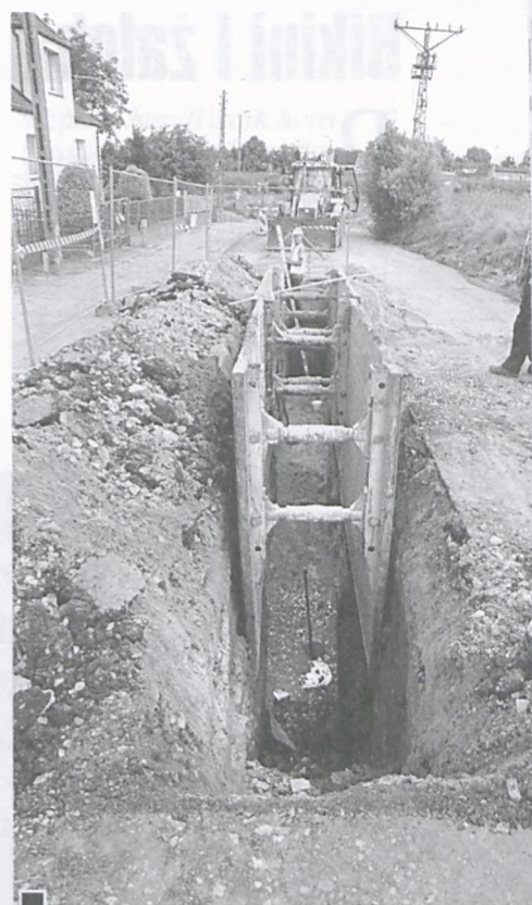
Budowa kanalizacji (fi 200) w ul. Podgórnej. Na innych ulicach, np. Fornalskiej, występują problemy z wodami gruntowymi i trzeba stosować podczas inwestycji igłofiltry odsysające wodę fot. Piotr P. Ruszkowski
