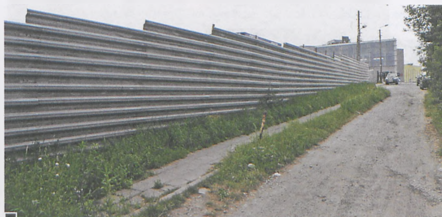
Ul. Paderewskiego zostanie utwardzona. Dzięki inwestycji powstanie w niej też kanalizacja deszczowa. Widok w kierunku ul. Żabikowskiej, w głębi widoczne Centrum Pajo, z lewej ogrodzony plac budowy fot. Katarzyna Polerowicz-Kelma
