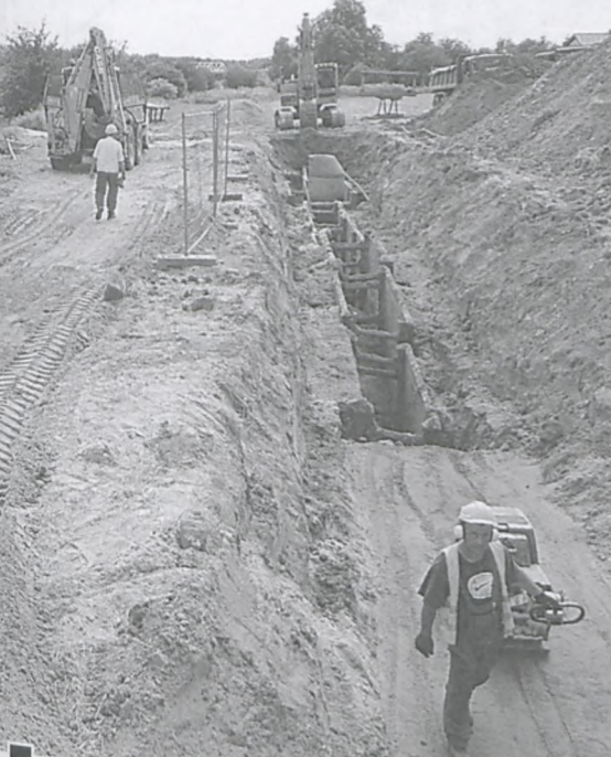
Zaawansowanie prac kanalizacyjnych w ul. Dworcowej. Do wlotu w ul. Krętą na wysokości wiaduktu kolejowego brakuje ok. 250 m fot. Piotr P. Ruszkowski
