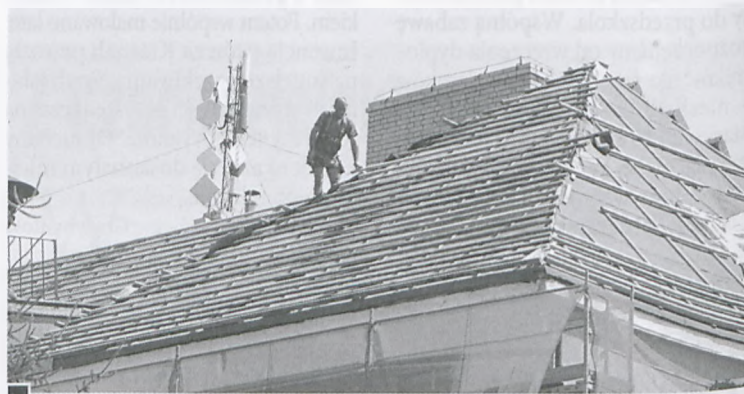
Wymiana łat i dachówki w SP 1 fot. Piotr P. Ruszkowski
