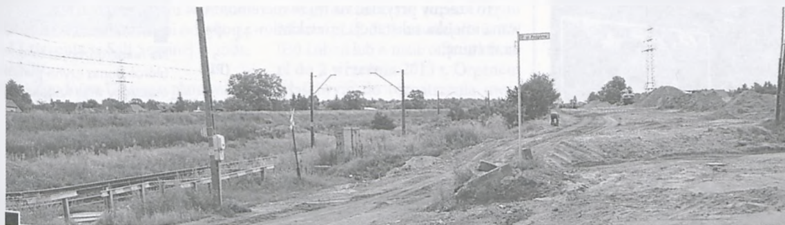
Kładzenie kanalizacji na dotychczas ślepych pasie ul. Dworcowej za ul. Podgórnej. Oprócz budowy ważnej infrastruktury prace przyczyniają się do udrożnienia ul. Dworcowej do Krętej. Z lewej – tory kolejowe fot. Piotr P. Ruszkowski
