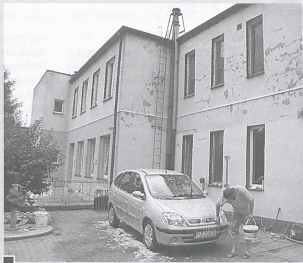
W ustronnym miejscu, na podwórzu publicznego przedszko-la – dzika myjnia samochodowa. Karygodne jest również, że proceder odbywa się w bezpośrednim sąsiedztwie studni z pompą (z lewej), do której przenika chemia ze środków czystości używanych do mycia aut fot. Piotr P. Ruszkowski
