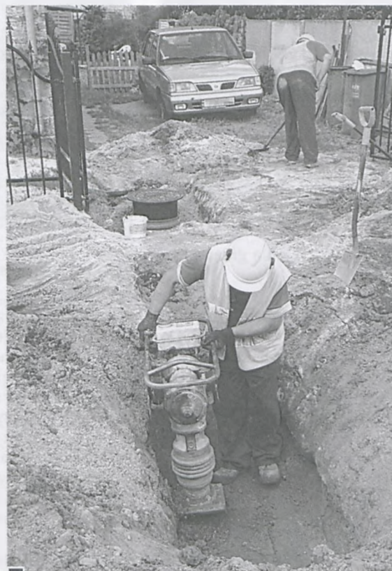
Przykład wykonywania przyłączy w ul. Wiejskiej z zastosowaniem mniejszej, plastikowej studzienki rewizyjnej (średnica 425 mm) fot. Piotr P. Ruszkowski
