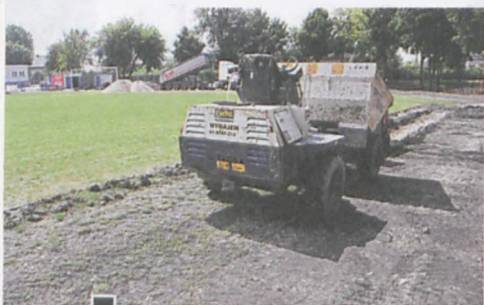
Wybieranie podłoża pod poszerzenie płyty stadionu. W oddali za bramką widać sterty żwiru i przywiezioną właśnie wielką wywrotkę czarnej ziemi – podłoża pod poszerzenie murawy fot. Piotr P. Ruszkowski
