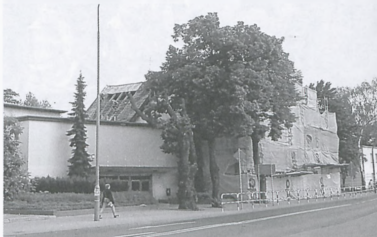
Gruntowny remont dachu SP 2 fot. Beata Stempczyńska
