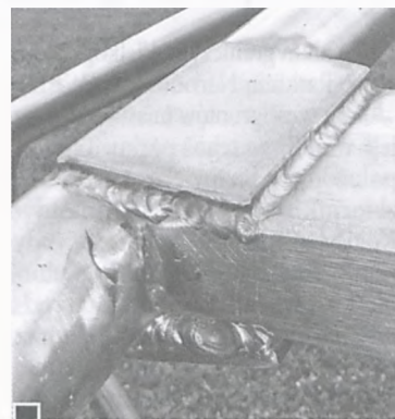
Widoczny świeży spaw łączący stalowe elementy urządzenia fot. Katarzyna Polerowicz-Kelma
