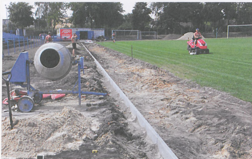
Przygotowywane pod poszerzenie płyty boiska do piłki nożnej kosztem bieżni 2,5 m pasy. Ułożone pierwotnie na betonowej podsypce krawężniki zostały następnie zdemonstrowane i zastąpione elementami z tworzywa sztucznego. Gospodarz obiektu (z prawej) – Andrzej Roszyk – po dosianiu trawy, zasilaniu specjalnymi nawozami oraz systematycznym podlewaniu, niekiedy dwa lub trzy razy w tygodniu, kosi płytę stadionu fot. Piotr P. Ruszkowski
