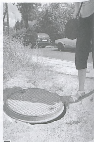
Na nieogrodzonym terenie, po rozbiorze domu czyha pułapka – źle osadzony właz kanalizacyjny fot. Piotr P. Ruszkowski
