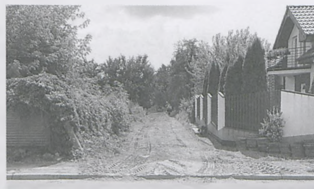
Wylot ul. Wiejskiej w Kwiatową. Po udrożnieniu ul. Wiejska będzie miała kształt litery „L” fot. Piotr P. Ruszkowski
