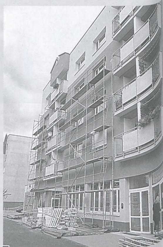
Po upływie roku od termomodernizacji przy blokach 51 i 53 na ul. Kościuszki ponownie rozstawiono rusztowania i prowadzono roboty fot. Hanna Siatka
