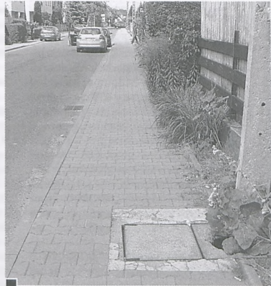
Dyskretnie przykryta liśćmi niebezpieczna dziura w pokrywie studzienki telekomunikacyjnej na chodni-ku ul. Niepodległości fot. Paweł Wolniewicz
