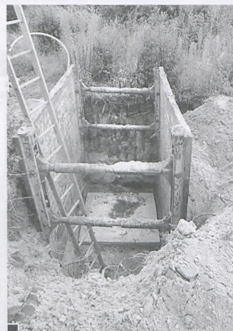
Działki niezagospodarowane (niezabudowane) uzbraja się, zgodnie z pierwotnym projektem technicznym, w studnie duże, ciężkie, betonowe – przykład z ul. Wiejskiej – widoczna płyta fundamentowa, na którą zostaną położone betonowe kręgi o średnicy wewnętrznej 1 m fot. Piotr P. Ruszkowski
