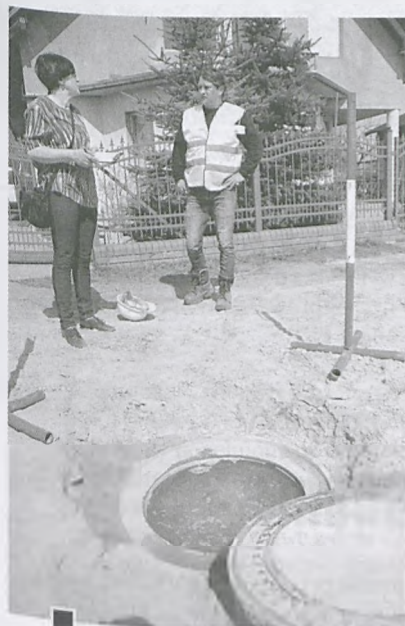
Próba szczelności odcinka kanalizacji w ul. Malwowej – 18 kwietnia br. fot. Piotr P. Ruzkowski
