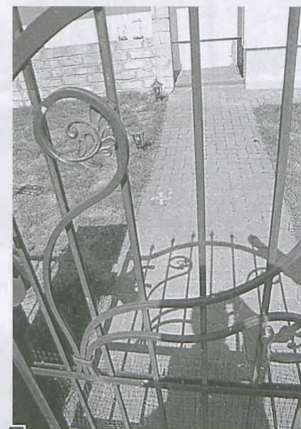
W wielu wypadkach absurdalnie zaprojektowano miejsca posadowienia studni na posesjach. Wypadają one w gankach, wjazdach, na zagospodarowanej zieleni, nie uwzględniając lokalizacji optymalnej dla działki. Według mieszkańców, projekt wykonano z za biurka, bez wizji lokalnej. Na zdjęciu przykład z ul. Malwowej – krzyżykiem zaznaczono planowaną lokalizację w chodniku, tymczasem obok jest ku temu wiele miejsca fot. Piotr P. Ruzkowski
