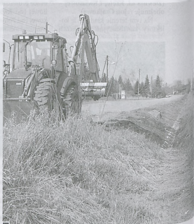
Usuwanie ziemi z rowu odwadniającego wzdłuż nieutwardzonej ul. Dworcowej fot. Piotr P. Ruszkowski
