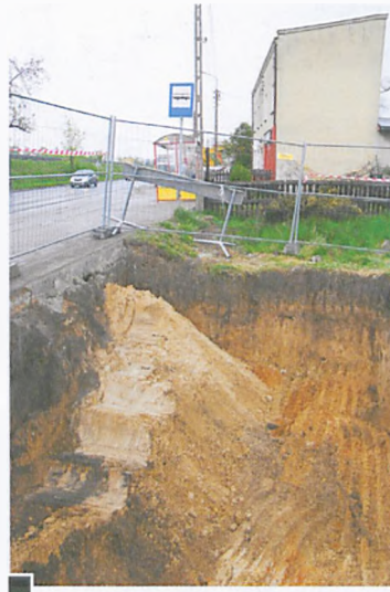
Dom na ul. Armii Poznań 95 (przy skrzyżowaniu z ul. Ratajczaka) przeznaczony jest do wyburzenia. Z miejsca pokazanego na zdjęciu wykonywany będzie przecisk pod budynkiem na znacznej głębokości fot. Piotr P. Ruskowski
