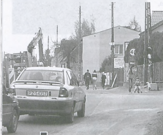
Ruch wahadłowy wyznaczony przez sygnalizację świetlną na wysokości ul. Podgórnej, w związku z przeprowadzanymi tam pracami fot. Paulina Sawicka
