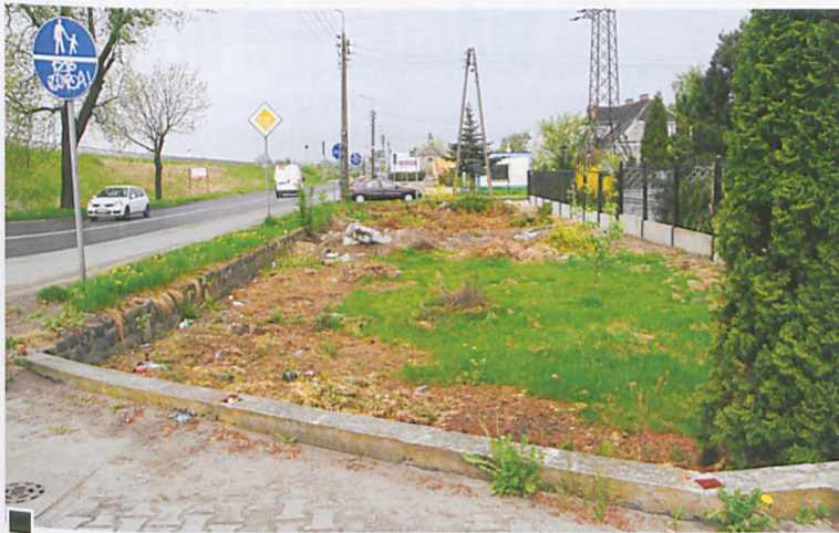
W pasie poszerzenia przyszłej drogi 430 (Armii Poznań), w miejscu drogi dojazdowej przesunięto ogrodzenia, usuwa się betony, drzewa i krzewy. Widok od ul. Paskowej w kierunku ul. Wawrzyniaka – stan z 7 maja br. fot. Piotr P. Ruskowski
