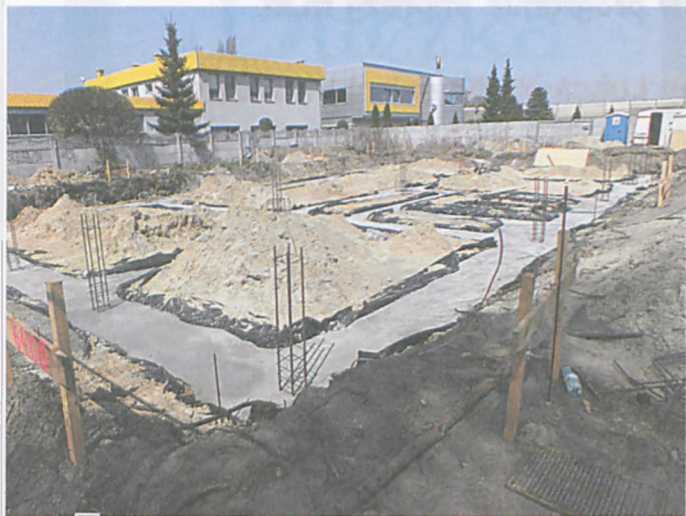
Fundamenty inwestycji firmy „Handrog” przy ul. Niepodległości. W głębi spółka „Niedźwiedź-Lock” fot. Hanna Siatka
