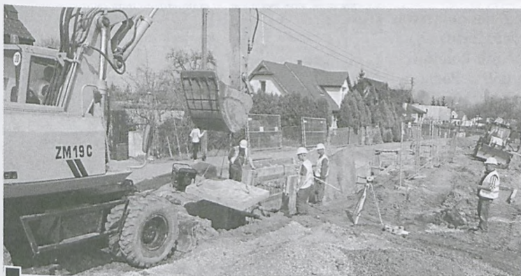
Montaż płyty fundamentowej pod studzienkę kanalizacyjną, wykonywany przez firmę Kan-Wod-Eko z Muszyny na ul. Kurowskiego – 24 kwietnia br. fot. Piotr P. Ruzkowski
