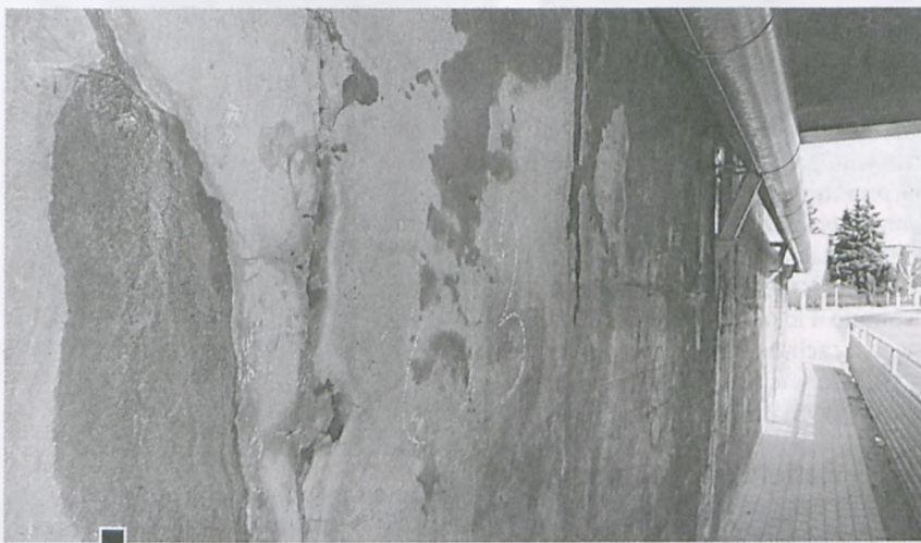
Spękane i wysięki ze ścian wiaduktu kolejowego przy ul. Powstańców Wlkp. fot. Piotr P. Ruskowski
