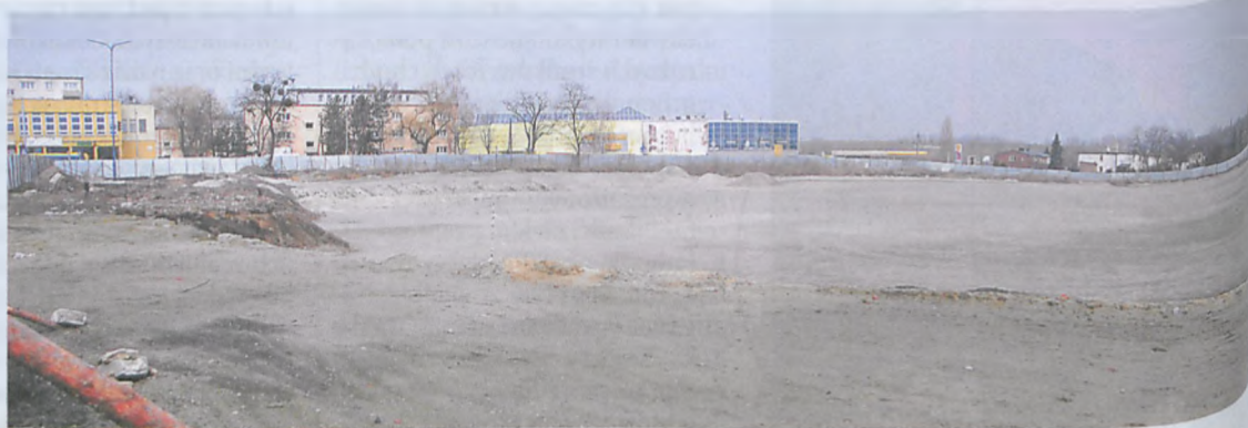
Nawieziony, wyrównany, utwardzony grunt pomiędzy ulicami Powstańców Wlkp., Żabikowską i Paderewskiego czeka na rozpoczęcie prac budowlanych fot. Piotr. P. Ruszkowski
