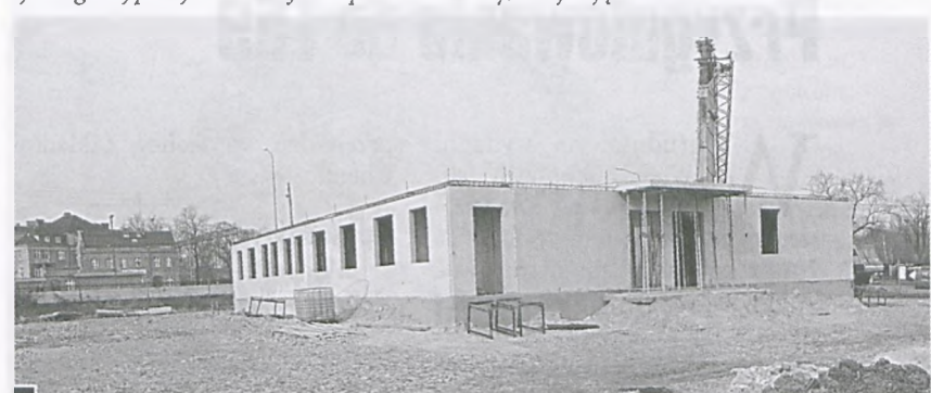
Pierwsza kondygnacja betonowych ścian jednego z „hotelu” już gotowa. Długa zima przerwała budowę bloku na kilka miesięcy fot. Piotr P. Ruszkowski
