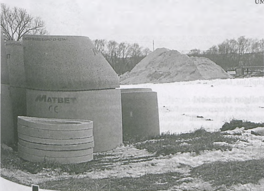
Pod koniec marca na pole przy ul. Podgórznej (między byłym salonem meblowym a firmą „Budmax”) zwieziono piasek, a później blisko jezdni zgromadzono betonowe kręgi. Po obydwu stronach ulicy ustawiono znaki ostrzegawcze, pod którymi widnieją tabliczki z napisem: „Wyjazd z budowy” fot. Paulina Sawicka
