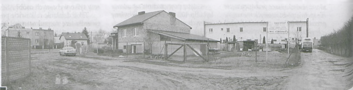
Widok od strony ul. Malinowej. Nierozwiązane połączenie z ul. Sobieskiego. Z lewej pas drogi kończący się na granicy działki 217. Tutaj, zgodnie z dokumentacją, przez wschodni skraj działki miało być połączenie do ul. Łącznej i dalej do Sobieskiego. Natomiast na drodze wprost, widać znajdujący się w jej pasie szczyt domu handlowego „Venus” fot. Piotr P. Ruszkowski
