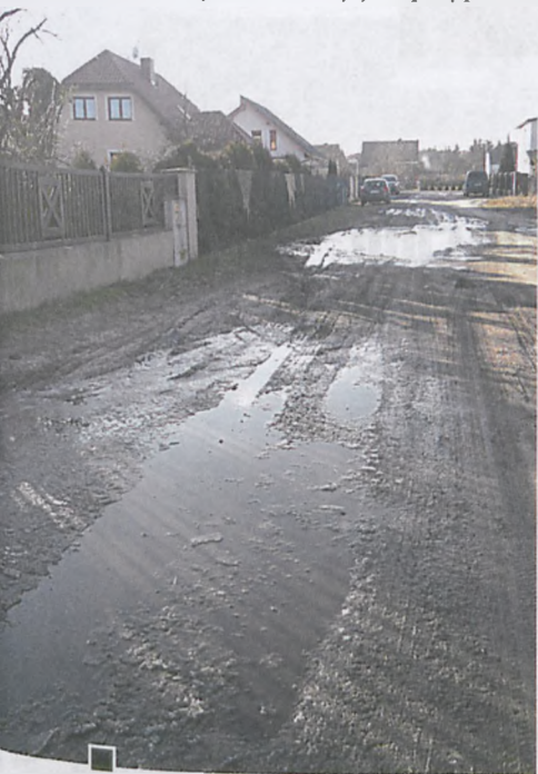
Ogromnej wielkości kałuże przy nieoświetlonej ul. Spornej fot. Paulina Sawicka
