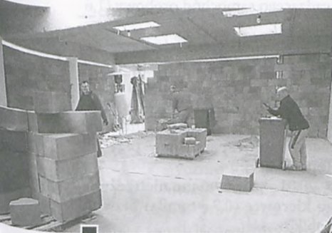
Budowa przyszłej podstrefy aerobiku fot. Władysław Szczepaniak
