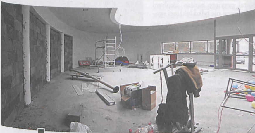
Adaptowany owal zajmować będzie strefa fitness. Na zdjęciu – budowa podstrefy siłowni w głównym pomieszczeniu fot. Władysław Szczepaniak
