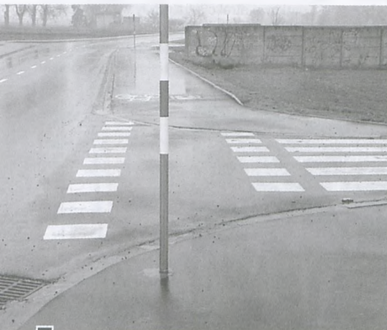
Znaki drogowe przy nieoświetlonej ul. Polnej, umieszczone na środku drogi dla rowerów, muszą skończyć się kolizją fot. Rafał Wojtyniak
