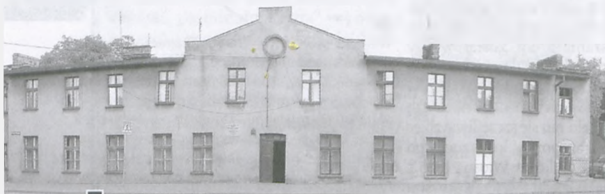
Budynek Wyższej Szkoły rolniczej w Żabikowie, z którą związani byli także powstańcy styczniowi fot. Piotr P. Ruskowski
