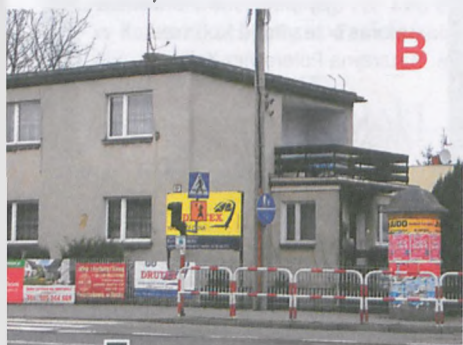
Przy skrzyżowaniu z ul. Dąbrowskiego znajduje się dom jednorodzinny z budynkiem gospodarczym o adresie ul. Armii Poznań 25 (mapka 1 – „B”), w przyszłości będzie tu rondo fot. Piotr P. Ruszkowski
