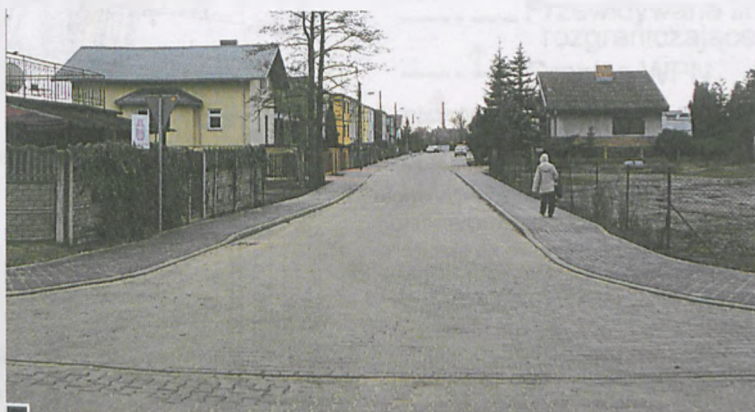
Ul. Ziemniaczana po remoncie. W głębi, po prawej stronie widoczny parking mogący pomieścić 10 samochodów fot. Paweł Wolniewicz
