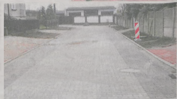
ul. Świerczewskiego w trakcie robót
