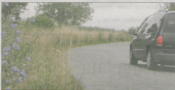
Kierowcy alarmują, że zarośnięte pobocza zagrażają bezpieczeństwu na powiatowych drogach, szczególnie przy skrzyżowaniach i zakrętach (na zdjęciu droga powiatowa w Roszkówku)
