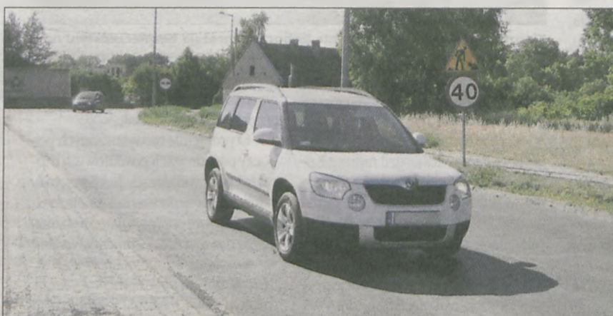
Kierowcy narzekają na fatalny stan ul. Powstańców Wlkp. w Jarocinie. Ich zdaniem kolejne łatanie dziur nie jest żadnym rozwiązaniem
