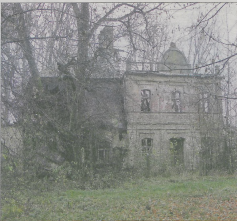
Pałac w Kotlinie jest kompletną ruiną
