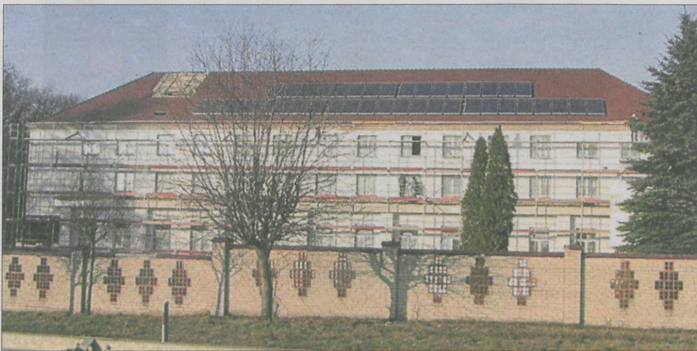
Kolektory słoneczne mają zapewnić częściowe pokrycie zapotrzebowania na ciepłą wodę w nowym DPS-ie
