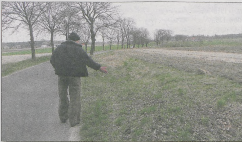
Bronisław Sobczak twierdzi, że zasypany rów przy polu radnego Janusza Szóstka spowoduje uszkodzenie drogi w Prusinowie
