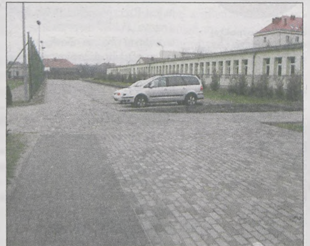
Wykonawcą nowej drogi była firma Brukarstwo Usługowe „Wald-Bruk” z Komorza Przybysławskiego
