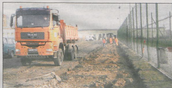
Pogoda sprzyja wykonawcy nowej drogi do szkolnych warsztatów przy jarocińskiej „dwójce”
